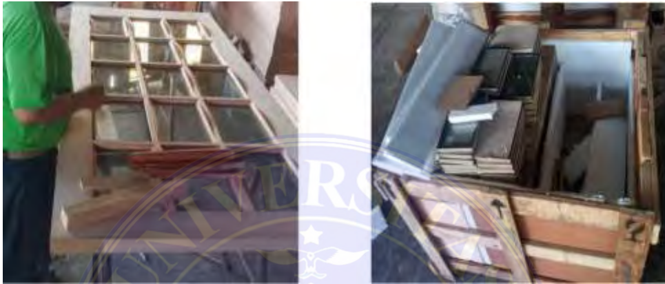
Gambar 3.46. Proses Pemasangan Biding Pakai Kaca Pada Komponen Pintu
