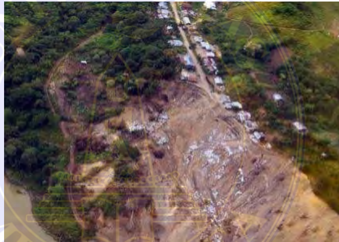
Gambar 2. 292 Kerusakan gempa bumi
