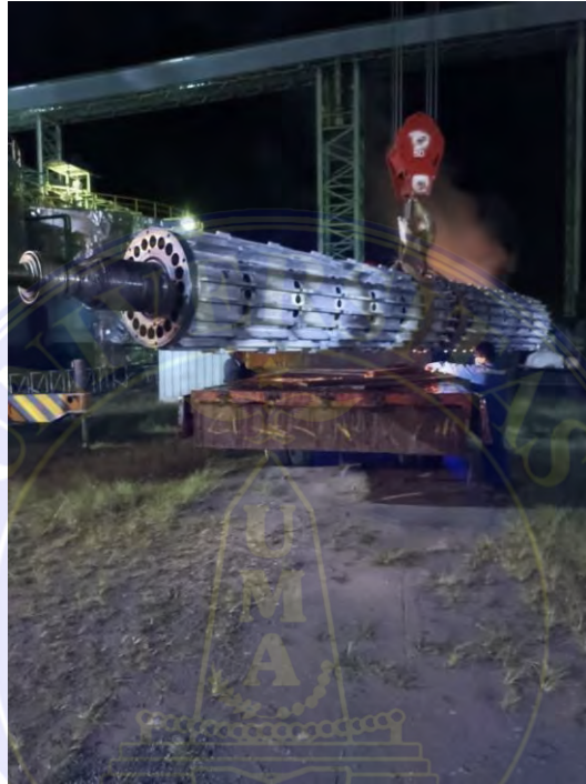
Gambar 3. 14 Pengangkatan CD filter
