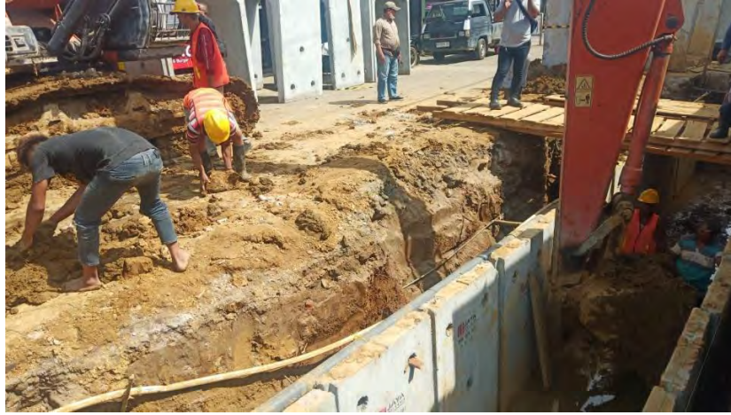
Kegiatan perbaikan pada parit yang akan dibeton
