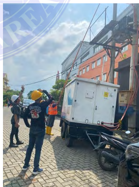
Mengganti fco dan pelepasan trafo back up dan melepaskan kabel jtr
