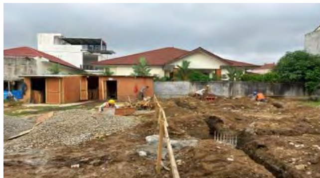
Gambar 2. 10 Proses Pembangunan Private Pavilliun Mrs.Kahiyang - Medan
