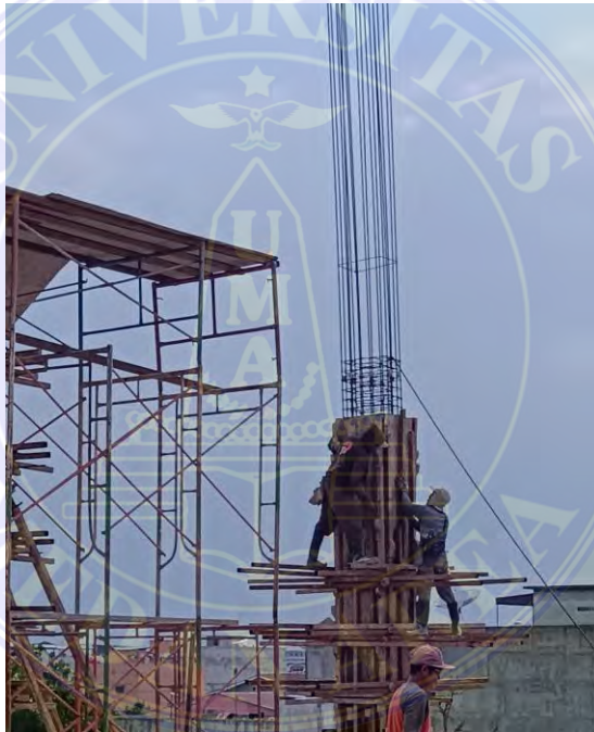
Gambar 4.5 Bekisting Kolom
