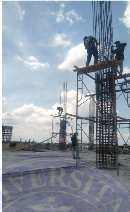
Gambar 4.3 Kolom Pada Lantai 3
