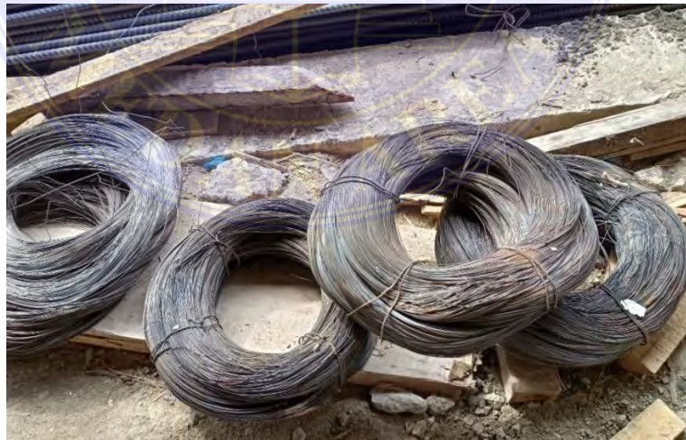
Gambar 3.33 Bendrat Sumber : Data Lapangan
