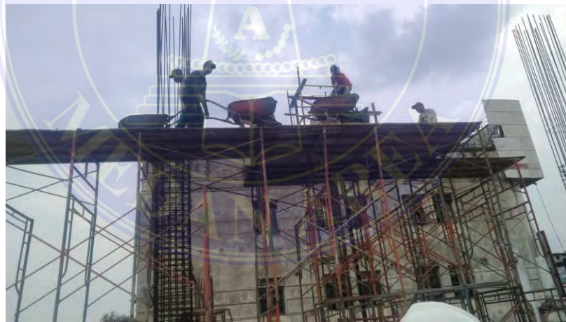
Gambar 4.6 Pengecoran Kolom
