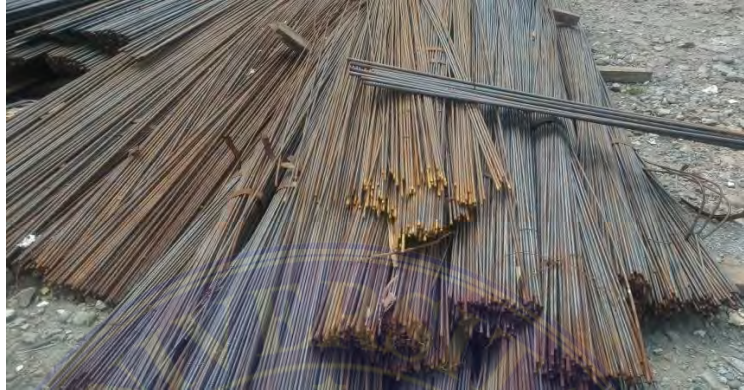
Gambar 3.32 Besi Tulangan Sumber : Data Lapangan
