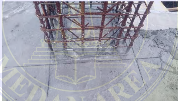
Gambar 4.4 Senggang Kolom
