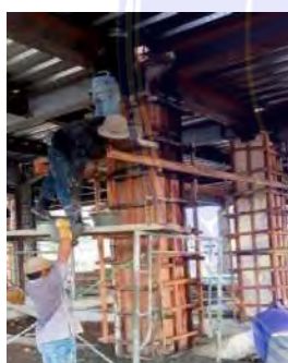
Pengecoran Kolom
