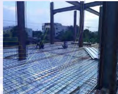
Gambar 3.6. Pemasangan bondex dan pemasangan wiremesh lantai 2
