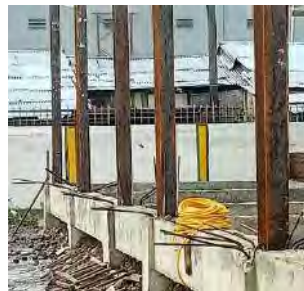
Pemasangan Baja WF
