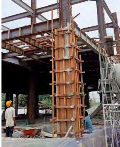
Gambar 3.5. Pengecoran kolom lantai 1 dan perakitan ring balok
