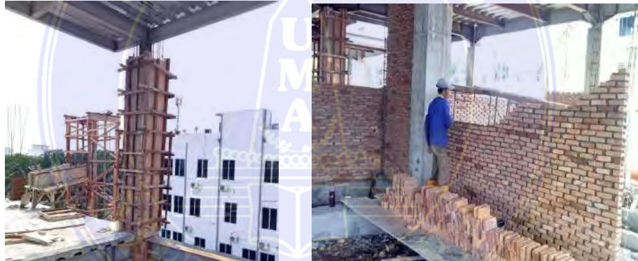
Gambar 3.12. Pengecoran kolom lantai 2 dan pemasangan batu bata di lantai 1
