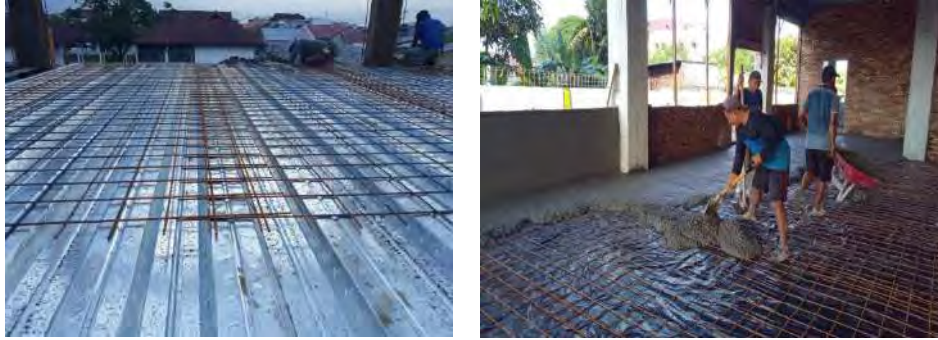
Gambar 3.11. Pemasangan besi wiremesh dan pengecoran lantai dasar
