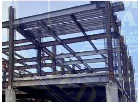
Gambar 3.6. Pemasangan bondex dan pemasangan wiremesh lantai 2
