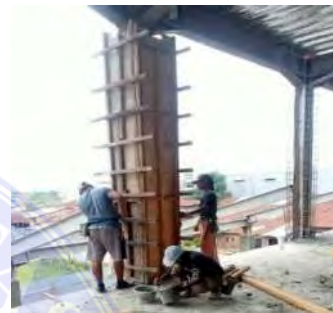
Pemasangan Bekisting
