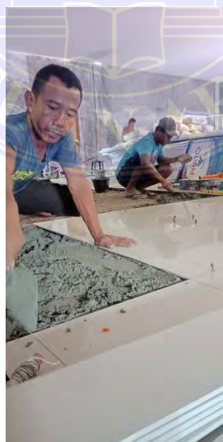
Gambar 55 : Proses Pemasangan lantai pada BP2RD ( Dokumentasi Penulis, 2022)
