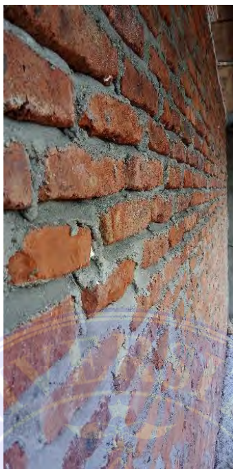
Gambar 33 : Material Bata pada Dinding BP2RD ( Dokumentasi Penulis, 2022)
