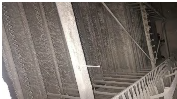
Gambar 2.8 Discharger Elektroda
