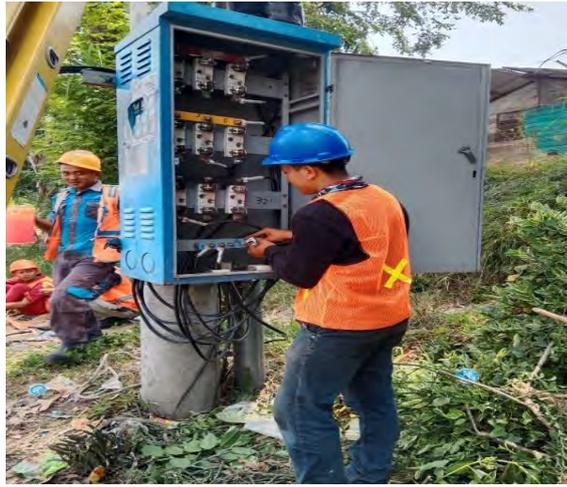
Gambar 3.2 Perawatan Papan Hubung Bagi.
