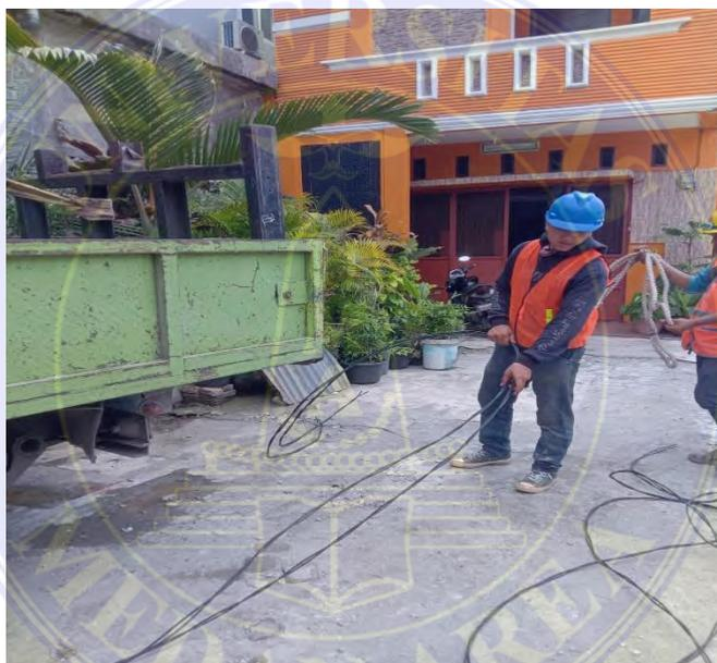
Gambar 3.4 Pemasangan Kabel SR.
