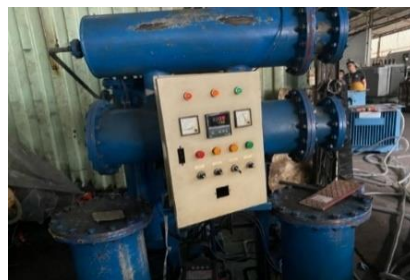
Gambar 3.5 Alat Purifikasi Minyak Trafo
