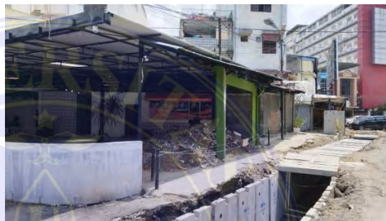
Gambar 3. 151 Keadaan bangunan yang sudah dibongkar
