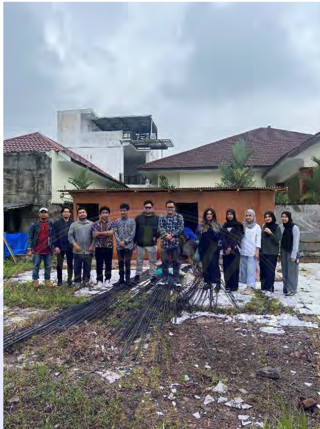
Gambar 4. 1 Peletakan batu pertama Rumah Bobby Kahiyang
