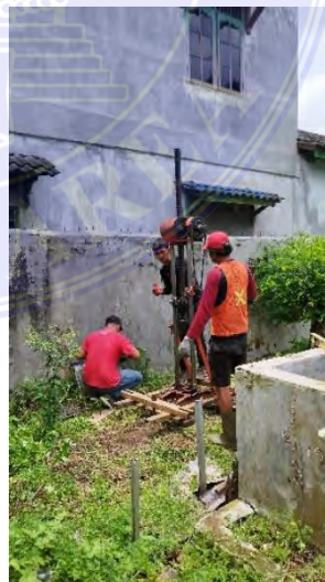
Gambar 3. 85 Proses tim sondir tanah mulai menguji tanah pada lahan rumah tinggal Mr Pulo Nababan.
