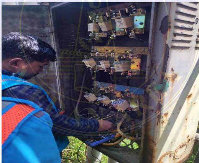
Gambar 3.3 Melakukan pengukuran pada PHB
