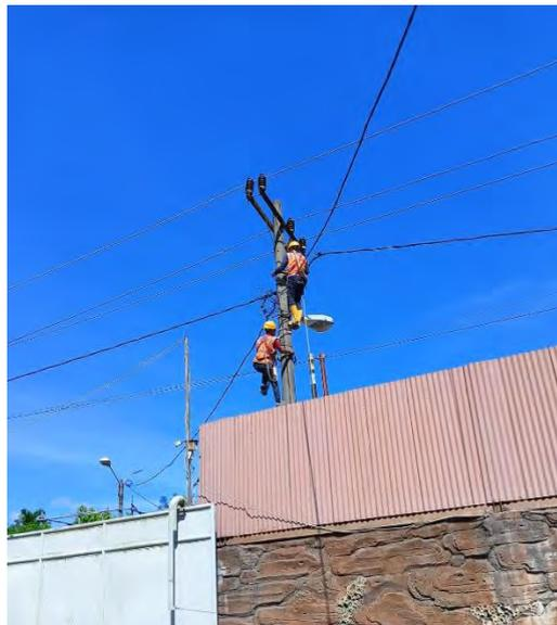
Gambar 3.9 Pemeliharaan pin isolator
