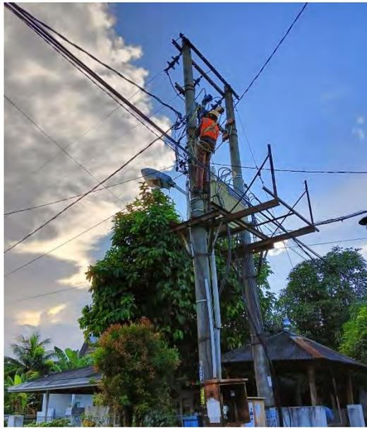
Gambar 3.8 Pemeliharaan Lightning Arrester
