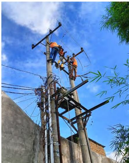
Gambar 3.7 Perbaikan Travers
