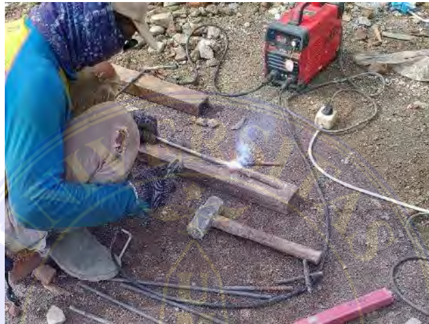
Gambar 3. 12 Las Listrik Sumber : Data Lapangan
