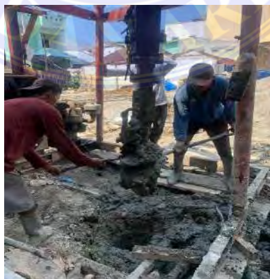
Gambar 4. 2 Pekerjaan Bore Pile Sumber : Data lapangan
