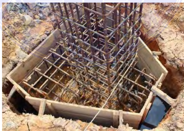
Gambar 3. 8 Bekisting Sumber : Data Lapangan
