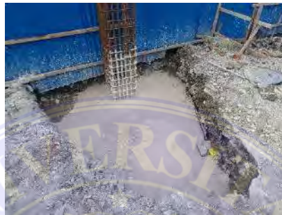
Gambar 4. 7 Pengecoran Pile Cap
