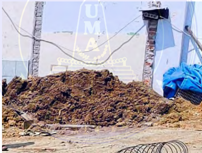
Gambar 3. 26 Tanah Timbunan Sumber : Data Lapangan
