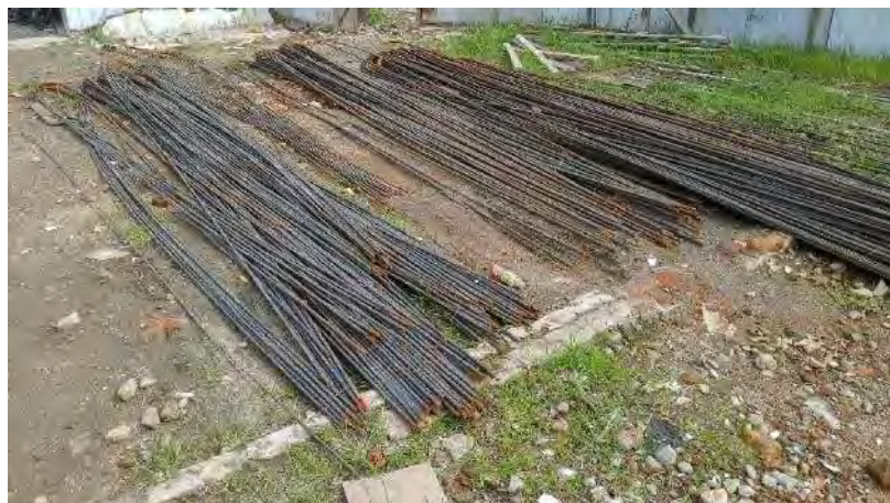
Gambar 3. 22 Besi Tulangan Sumber : Data Lapangan
