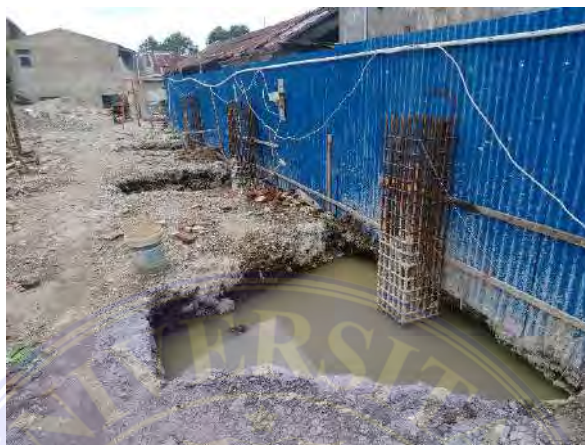
Gambar 4. 9 Perawatan Beton Pile Cap Sumber : Data Lapangan
