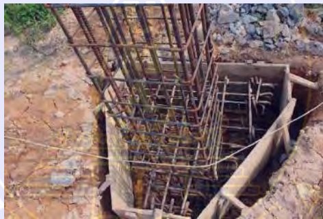
Gambar 4. 6 Pembuatan Bekisting Pile Cap Sumber : Data Lapangan
