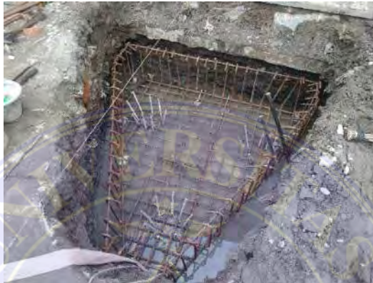
Gambar 4. 5 Penulangan Pile Cap
