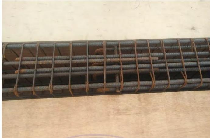
Gambar 4.3.6 Gambar Pembesian pada Balok
