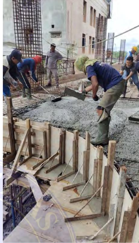
Gambar 2. Pengecoran
