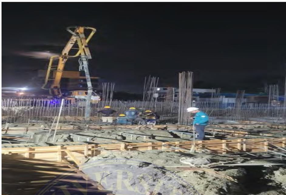
Gambar 5. Pengecoran Pondasi
