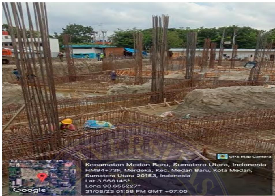
Gambar 1. Pemasangan Penulangan Pondasi
