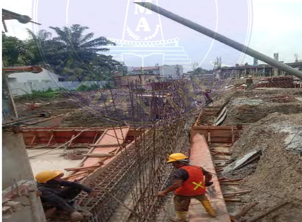
Gambar 8. Penulangan dinding penahan tanah
