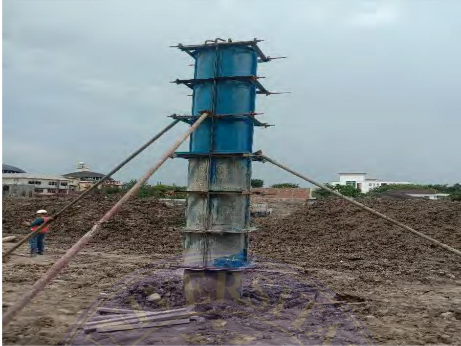
Gambar 4.8. Pemasangan penyangga bekisting, Sumber: Data Lapangan 2023
