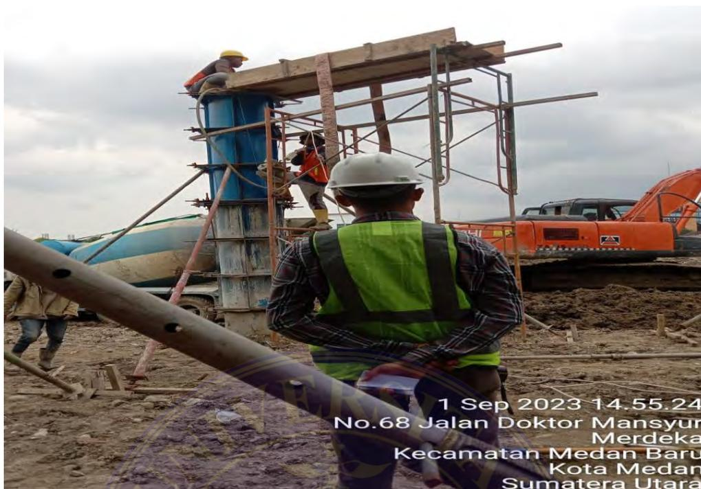
Gambar 7. Pengecoran Kolom Manual
