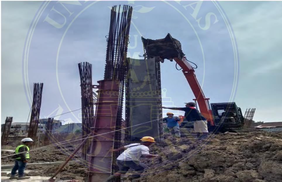
Gambar 4.7. Pemasangan *bekisting* kolom,
