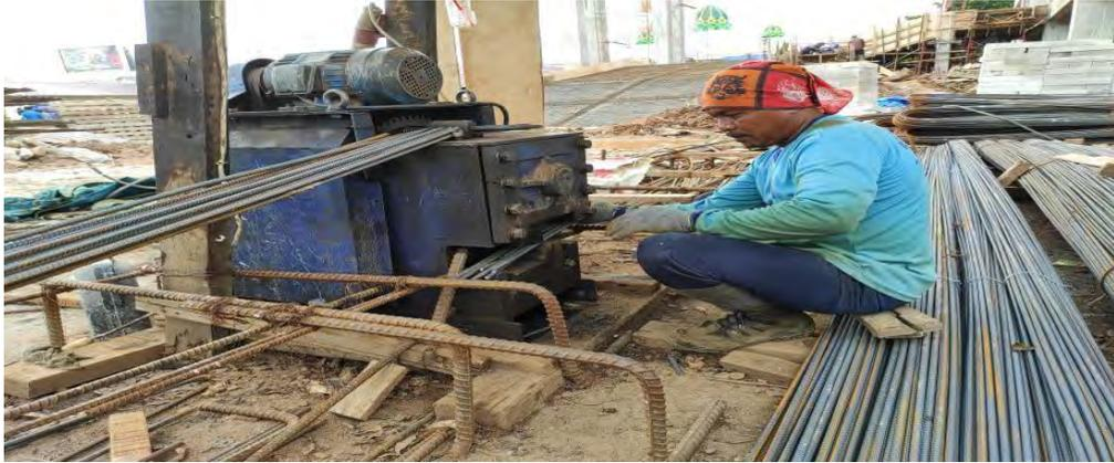
Gambar 4.1. Pemotongan besi tulangan,
