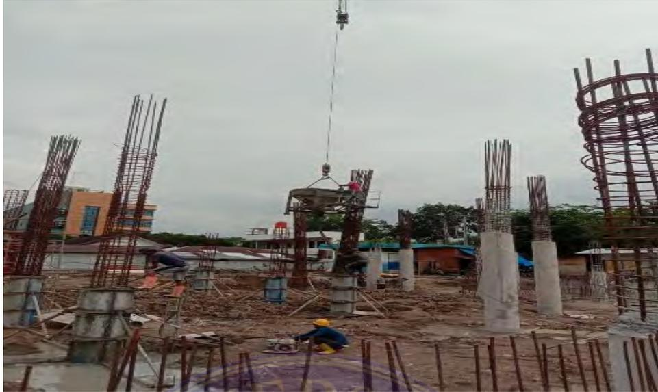
Gambar 4.11. Proses pengecoran kolom,
