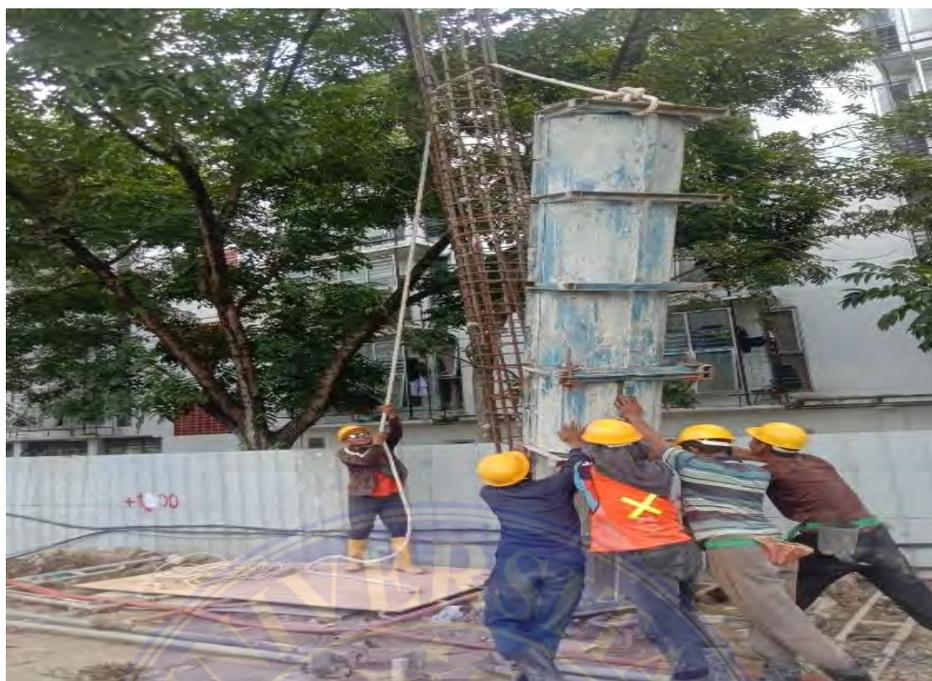
Gambar 3. Pemasangan Bekisting Kolom
