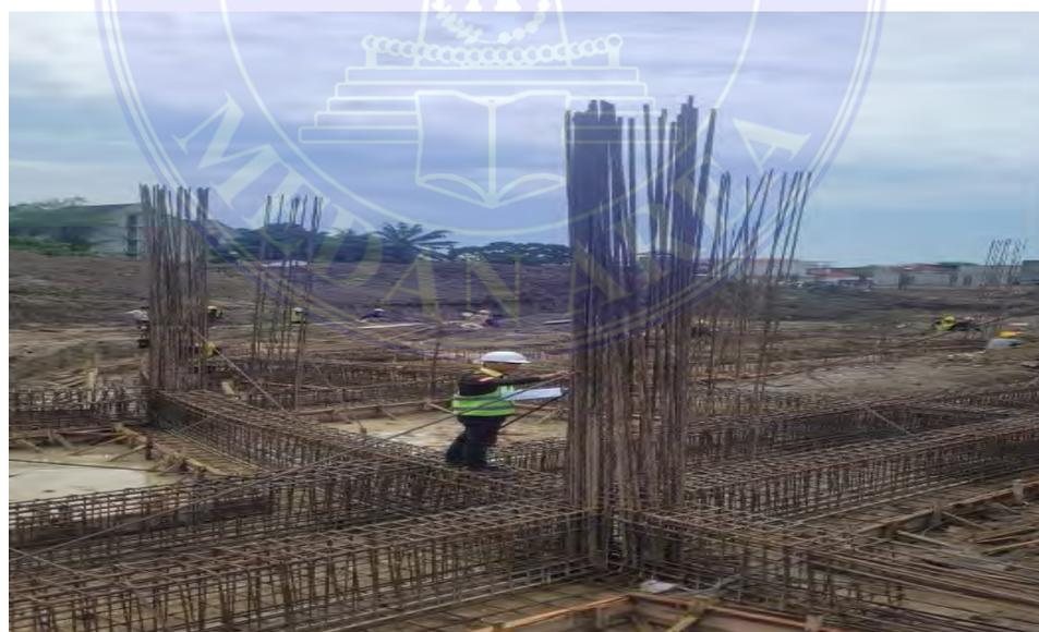
Gambar 2. Mengecek Tulangan Utama Pada Kolom
