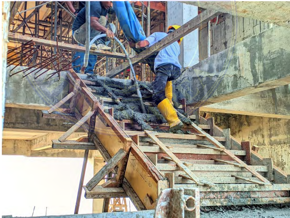
Gambar 4 Pengecoran tangga
