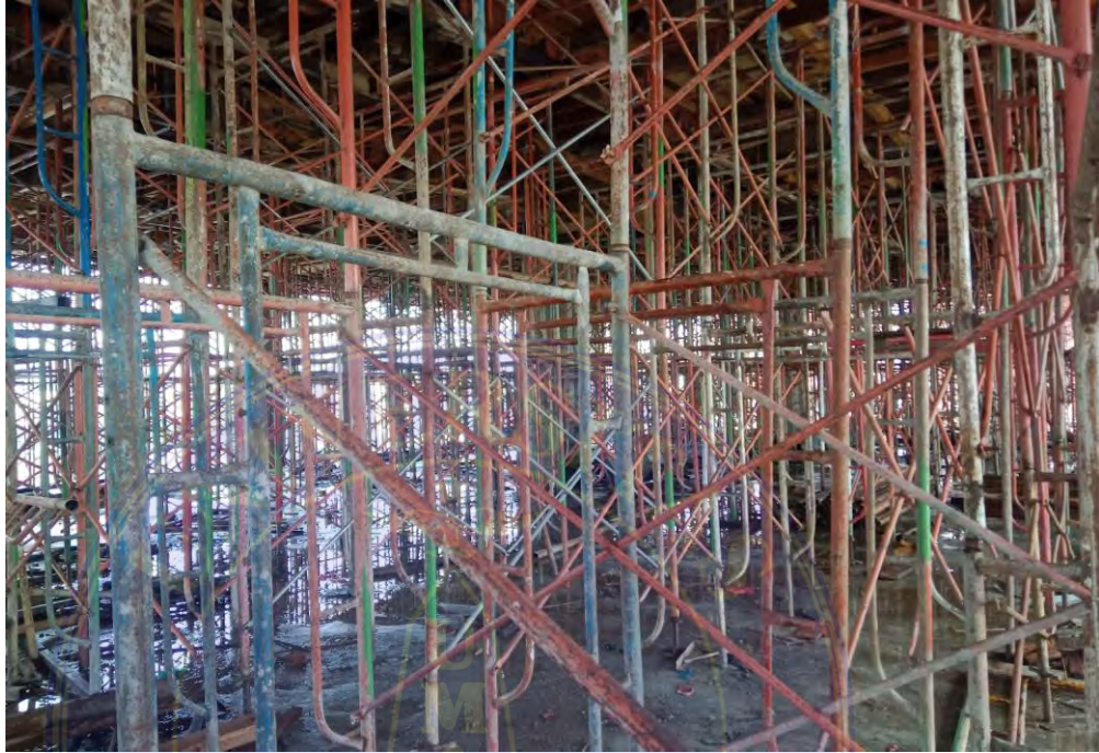
Gambar 1 Pemasangan Scaffolding Sumber: Data Lapangan
