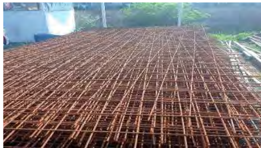
Gambar 3.2.14 Wiremesh Sumber : Data Lapangan
