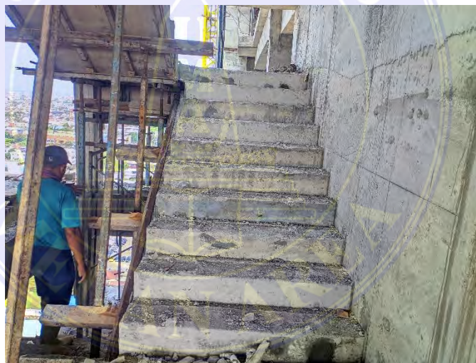
Gambar 4.3.6 Pembongkaran Bekisting Tangga
