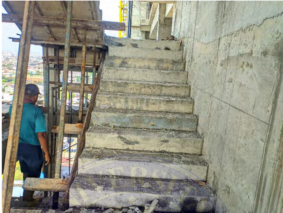
Gambar 5 Pembongkaran Bekisting Tangga
