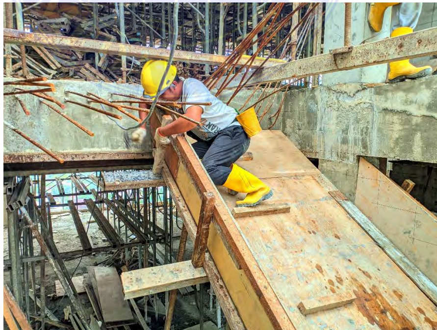
Gambar 2 Pemasangan bekisting Tangga
