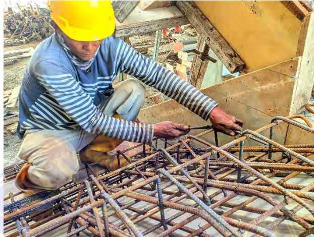
Gambar 4.3.4 Pemasangan Penulangan Tangga
