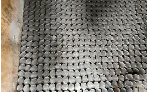
Gambar 3.2.12 Beton Decking Sumber : Data Lapangan
