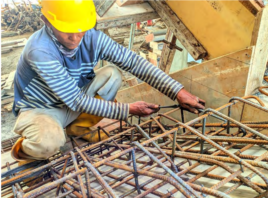
Gambar 3 Pemasangan penulangan Tangga
