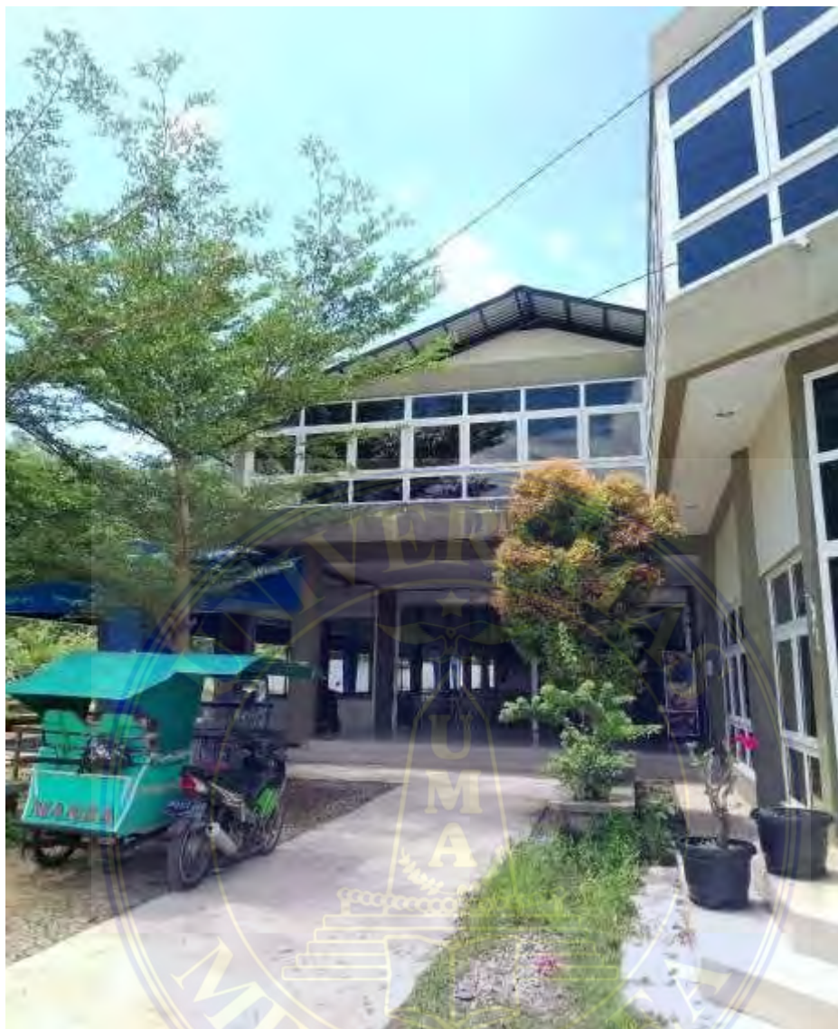
Gambar 5.7. Kondisi Gedung Food Court Di Objek Wisata Pantai Ujung Sibolga, Desa Simare-mare, Kota Sibolga
