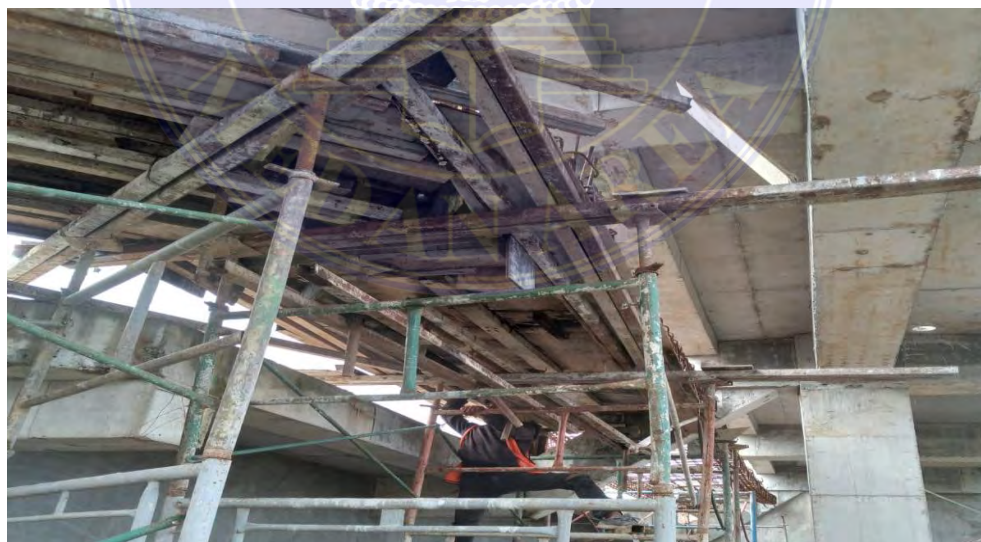
Gambar 2 Pemasangan bekisting Lantai
