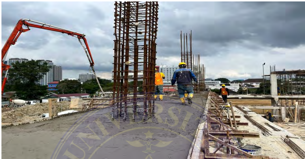
Gambar 10 : Pengecoran Pelat Lantai Tribun
