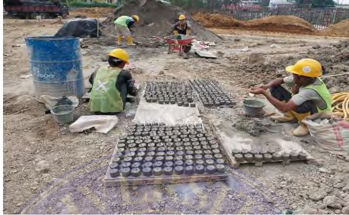
Gambar 3.44 Beton Decking Sumber : Dokumentasi Lapangan
