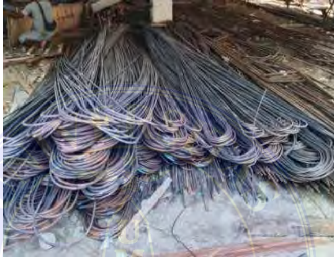
Gambar 3.34 Besi Tulangan Sumber : Dokumentasi Lapangan
