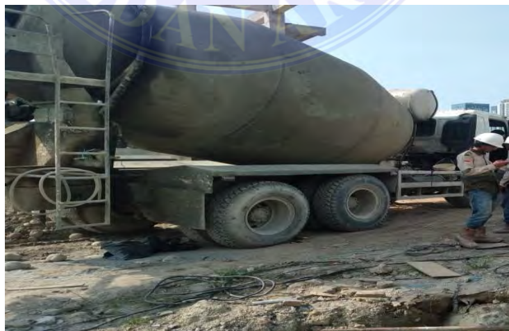
Gambar 3.9 Truck Mixer Beton Sumber : Dokumentasi Lapangan
