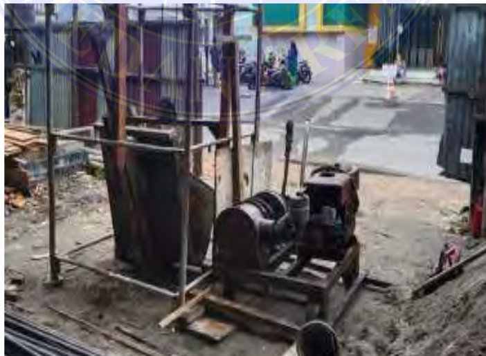
Gambar 3.28 Bucket Cor Sumber : Dokumentasi Lapangan
