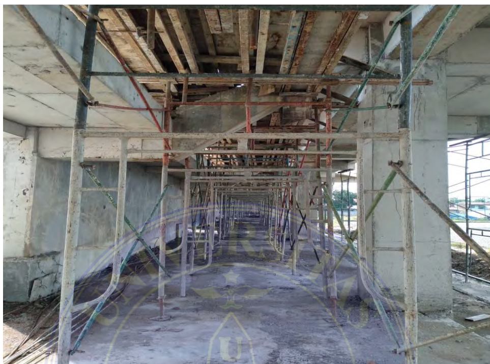
Gambar 1 Pemasangan Scaffolding
