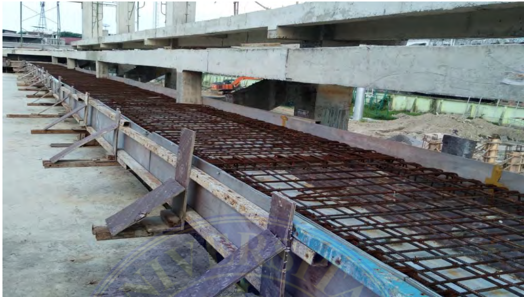
Gambar 7 : Tulangan Pelat Lantai
