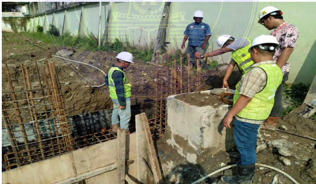
Gambar 11 : Pengecekan Tulangan Pondasi Videotron
