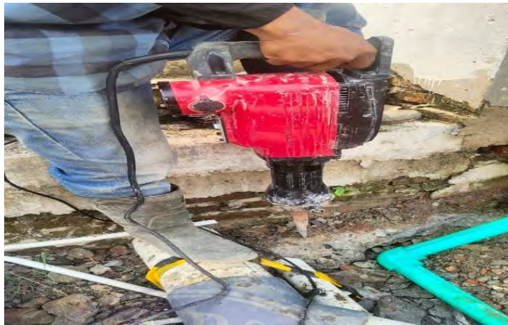
Gambar 3.3 Jack Hammer Sumber : Dokumentasi Lapangan
