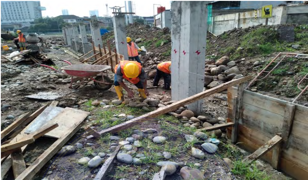
Gambar 12 : Pemasangan Batukali DPT
