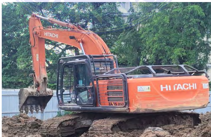
Gambar 3.30 Excavator Sumber : Dokumentasi Lapangan
