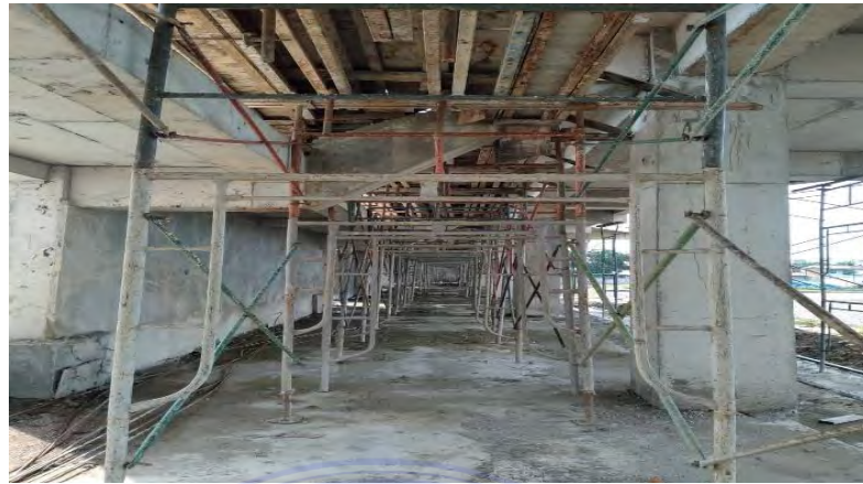
Gambar 4.10 Pemasangan Scaffolding Sumber : Dokumentasi Lapangan
