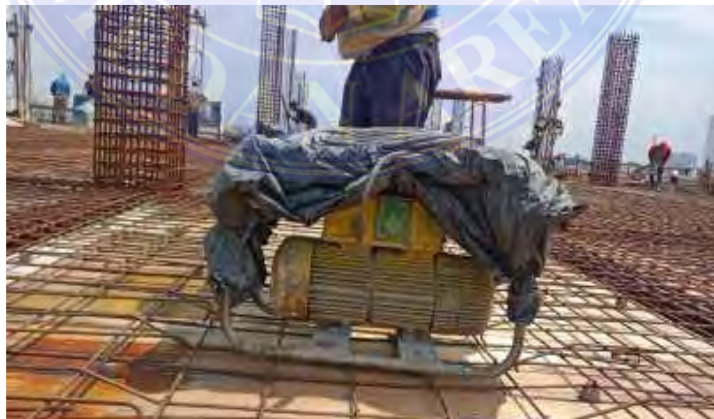
Gambar 3.4 Vibrator Sumber : Dokumentasi Lapangan
