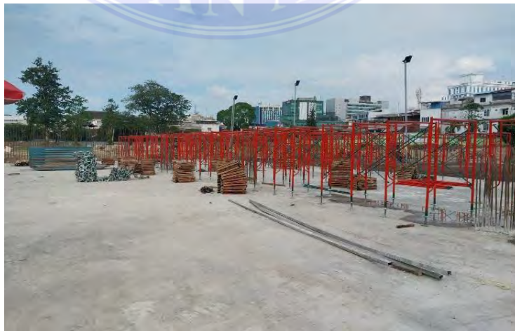
Gambar 3.18 Scaffolding Sumber : Dokumentasi Lapangan
