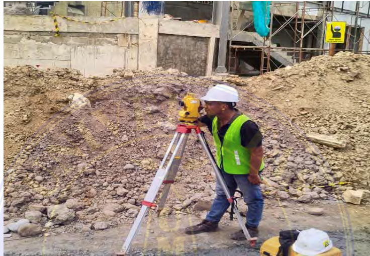
Gambar 3.31 Waterpass Sumber : Dokumentasi Lapangan
