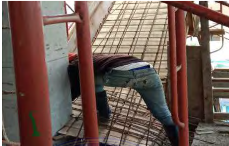
4.12 Pemasangan Penulangan pelat lantai Sumber : Dokumentasi Lapangan
