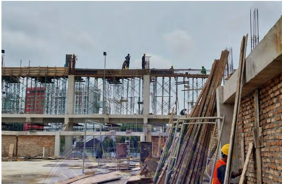
Gambar 5 Pembongkaran Bekisting Lantai
