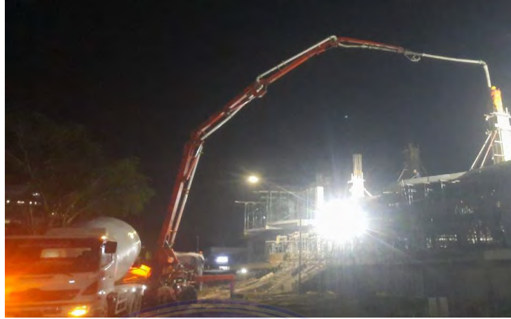
Gambar 3.32 Concrete Pump Sumber : Dokumentasi Lapangan
