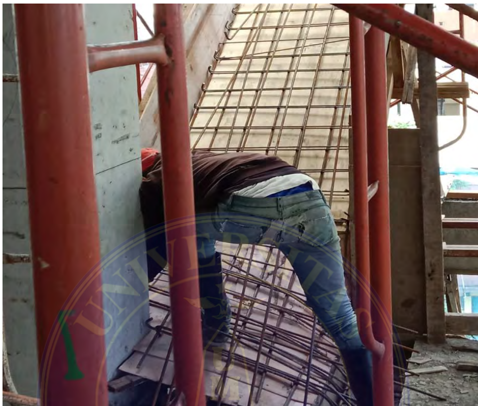
Gambar 3 Pemasangan penulangan Pelat Lantai
