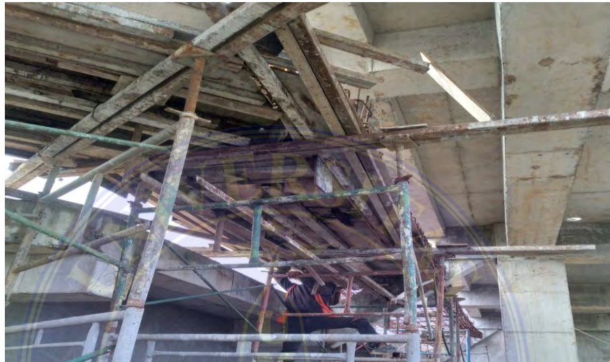
4.11 Pemasangan Bekisting pelat lantai Sumber : Dokumentasi Lapangan
