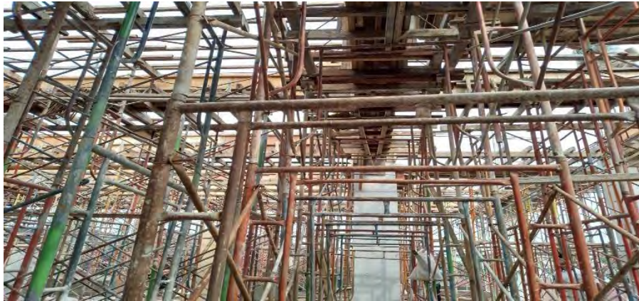
Gambar 4.3..7 Gambar Scaffolding Sumber : Dokumentasi Proyek
