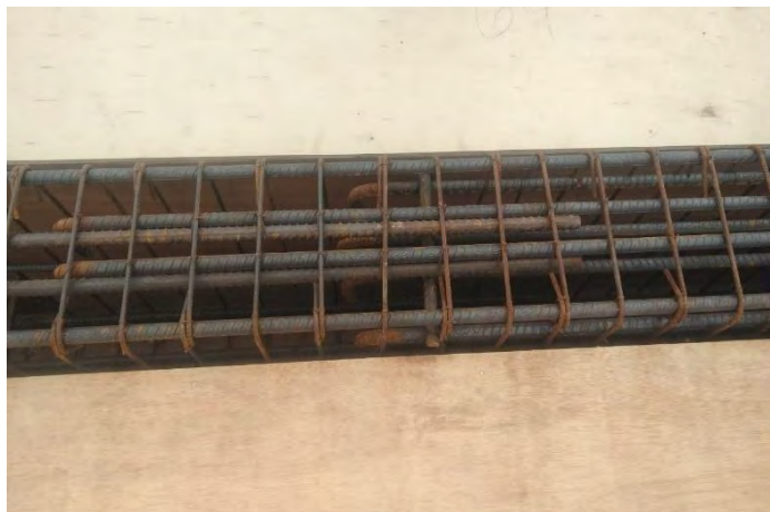
Gambar 4.3.6 Gambar Pembesian pada Balok
