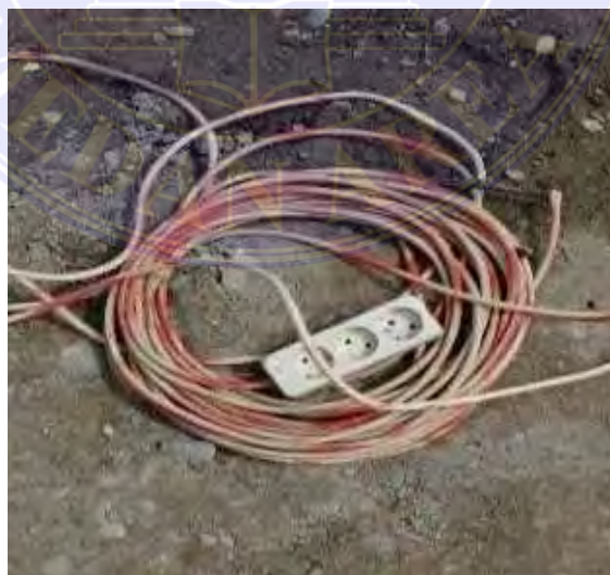
Gambar 3.1.23 Cok Sambung Sumber : Dokumentasi Proyek
