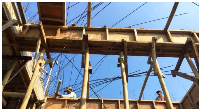
Gambar 3.1.8 Bekisting Sumber : Dokumentasi Proyek
