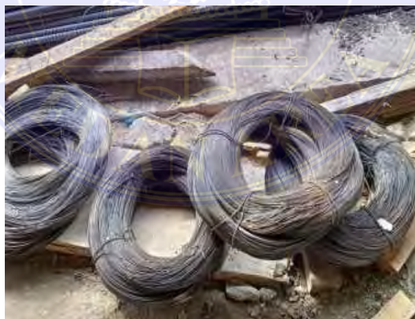
Gambar 3.2.3 Bendrat Sumber : Dokumentasi Proyek
