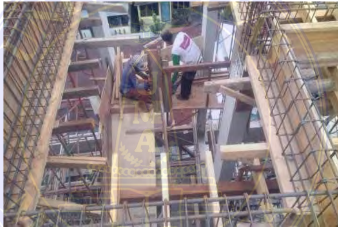
Gambar 4.3..8 Pemasangan Bekisting Balok Sumber : Dokumentasi Proyek
