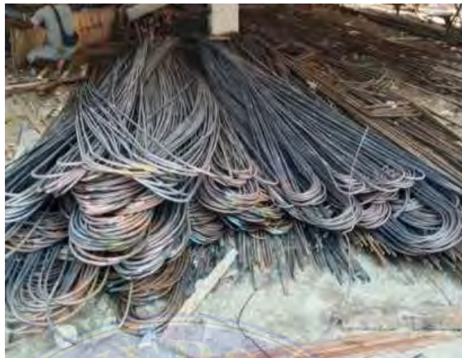
Gambar 3.2.2 Besi Tulangan Sumber : Dokumentasi Proyek
