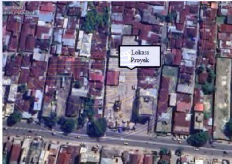
Gambar 2.1 Lokasi Proyek Sumber : Dokumentasi Proyek
