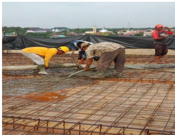
Gambar 4.3.9 Gambar Pengecoran Sumber : Dokumentasi Proyek
