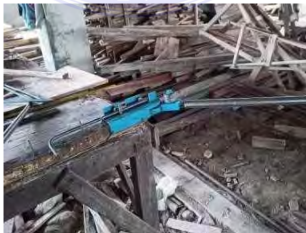
Gambar 3.1.27 Bar Bender Sumber : Dokumentasi Proyek
