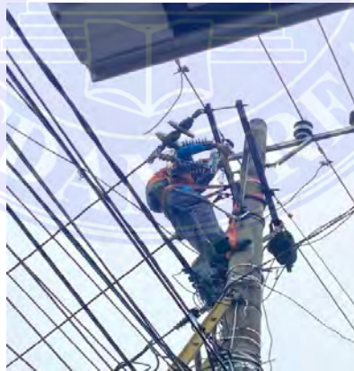
Gambar 3.10 Pemasangan Disconnection Switch
