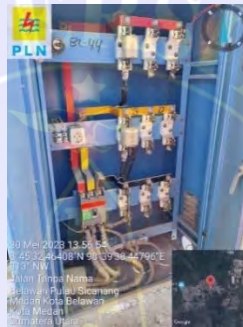
Gambar 3.6 Pemeliharaan PHB TR
