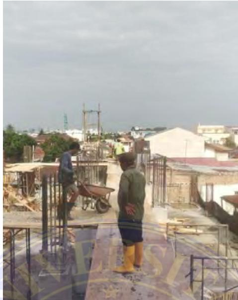
Gambar 5. 4 Proses pengecoran Kolom
