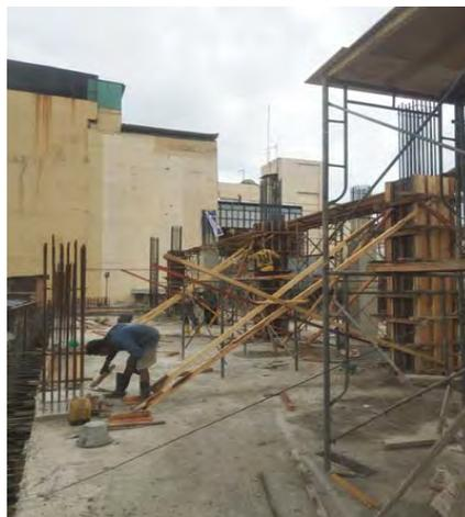
Gambar 5.3 Pemasangan bekisting kolom
