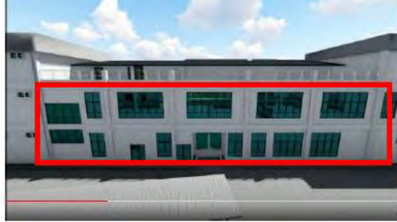
Gambar 2. 67 Tampak Posisi Jendela Jungkit Lantai 1 dan Lantai 2 (Sumber : Fairuza & Syamsiah, 2022 )
