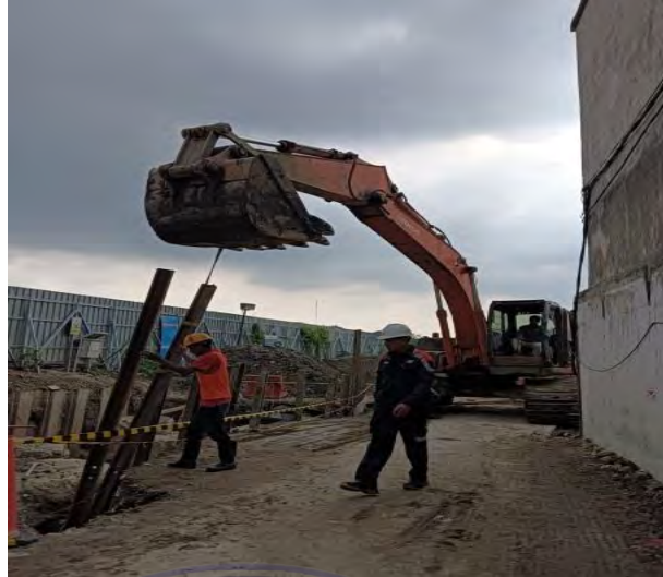
Gambar 4.3.2 Penggalian Tanah Sumber : Data Lapangan
