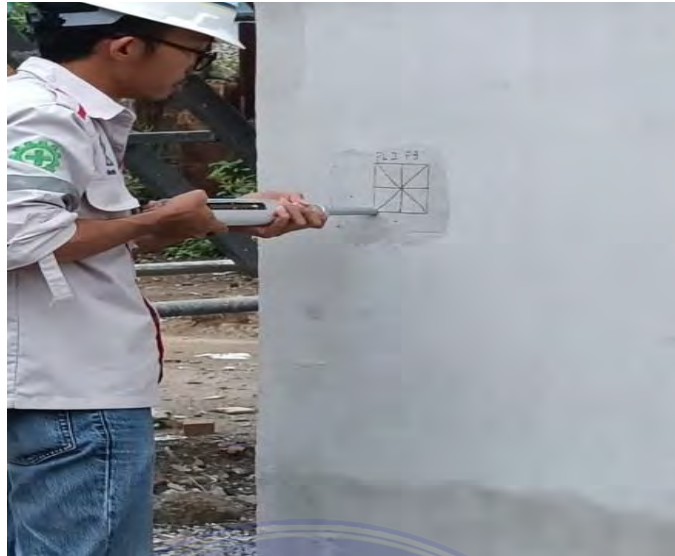
Gambar 4.3,8 Hammer Test Sumber : Data Lapangan
