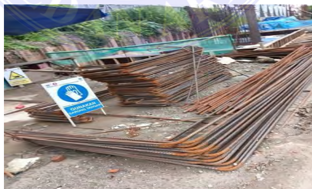
Gambar 2.2.1 Besi Tulangan Sumber : Data Lapangan
