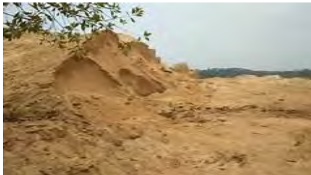
Gambar 2.2.4 Tanah Timbunan Sumber : Data Lapangan
