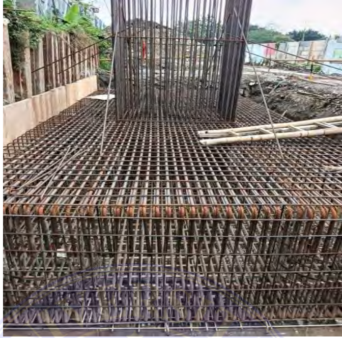
Gambar 4.3.5 Penulangan Pile cap Sumber : Data Lapangan
