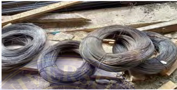
Gambar 2.2.2 Bendrat Sumber : Data Lapangan
