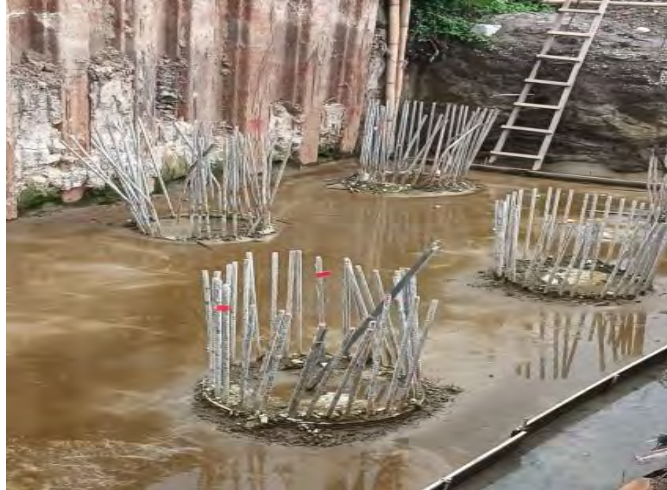
Gambar 4.3.4 Lantai Kerja Sumber : Data Lapangan
