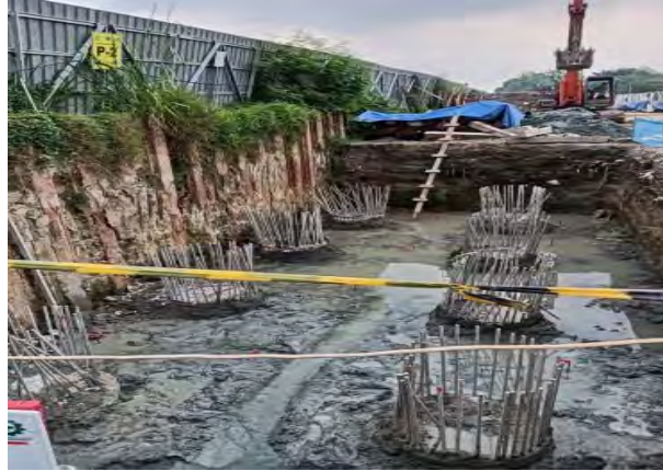
Gambar 4.3.3 Pembobokan Sumber : Data Lapangan
