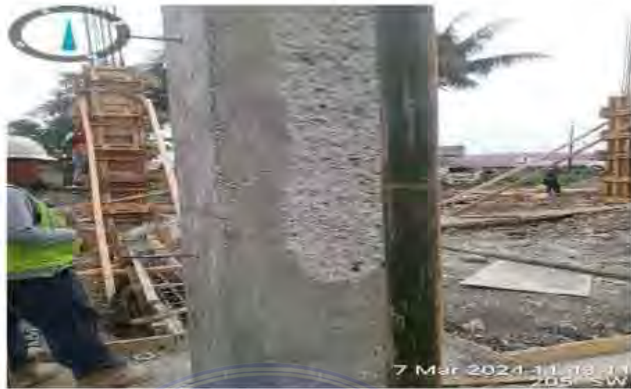
Gambar 4.6 Tahap Perawatan Sumber : Dokumentasi Lapangan
