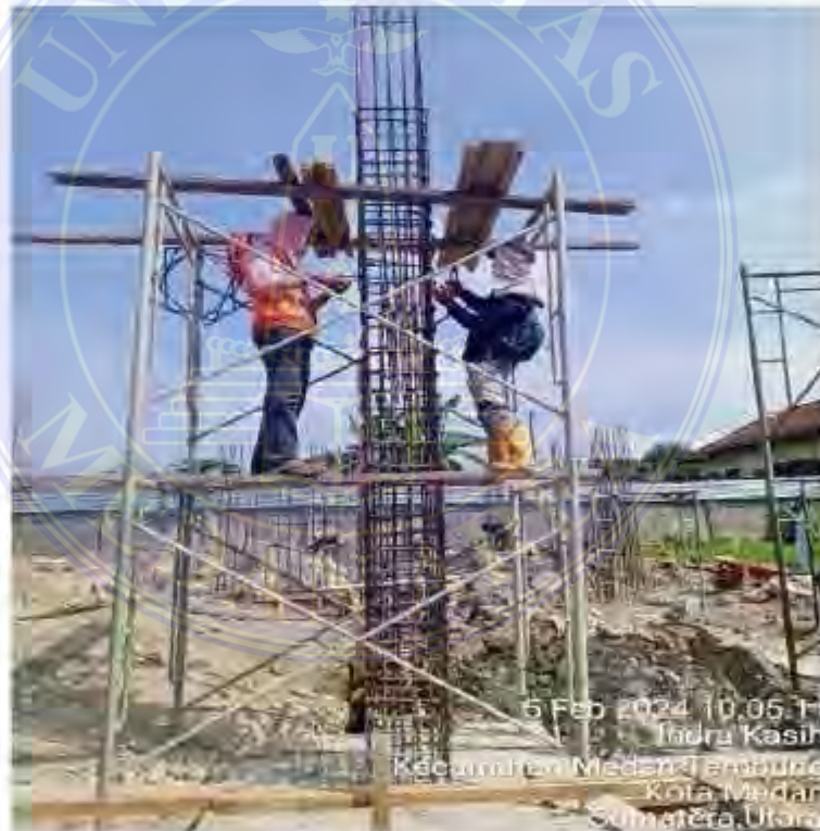
Gambar 4.2 Pekerjaan Pembesian Kolom
