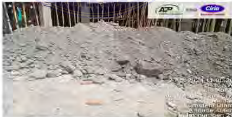
Gambar 3.19 Tanah Timbunan Sumber : Dokumentasi Lapangan
