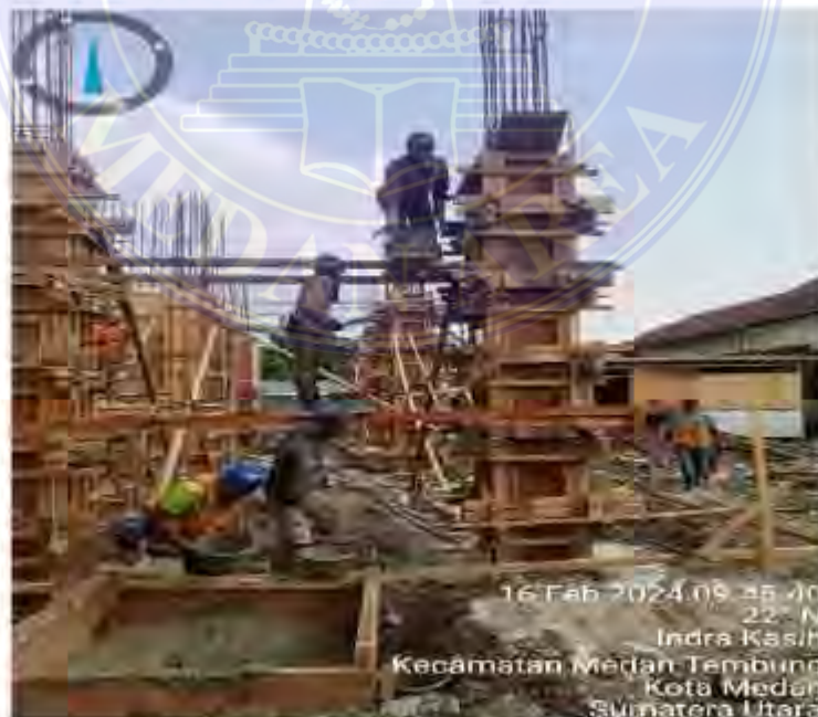
Gambar 4. 4 Proses pengecoran Kolom
