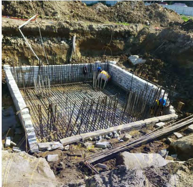
Gambar. Proses Penulangan dan Bekisting
