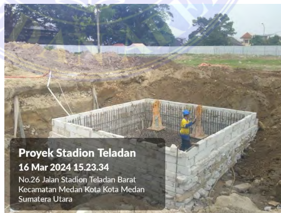
Gambar 4.15 Pembuatan dudukan dan peletakan anchor
