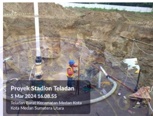
Gambar 4.13 Pembobotan Bore pile
