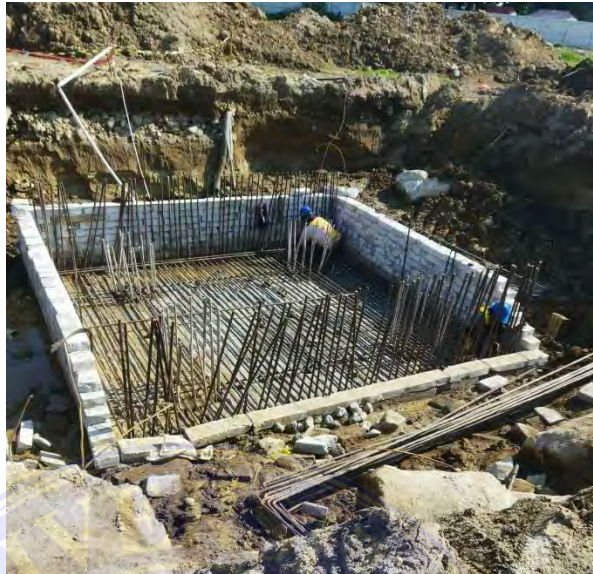
Gambar 4.14 Perakitan Tulangan dan Pemasangan Bekisting
