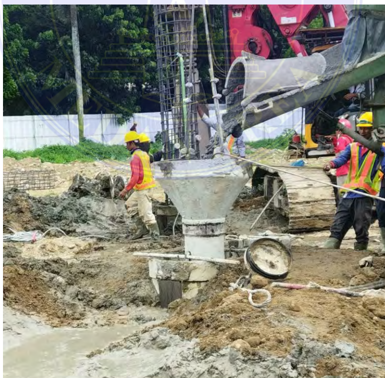
Gambar. Proses Pengecoran
