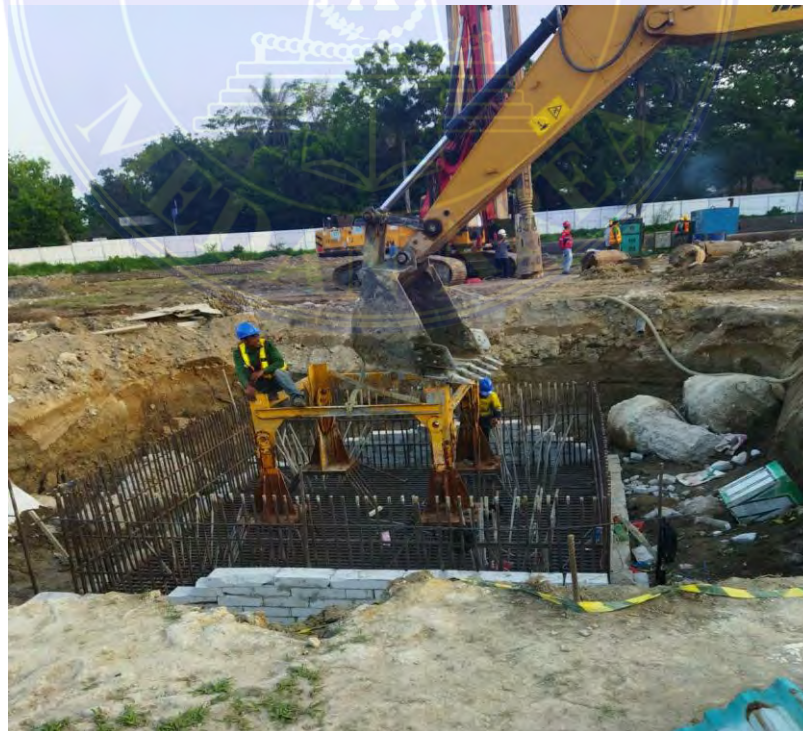
Gambar. Proses Peletakan Anchor
