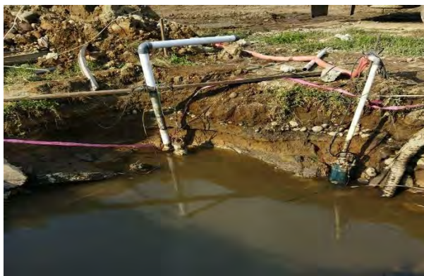
Gambar 4.6 Pompa Diturunkan
