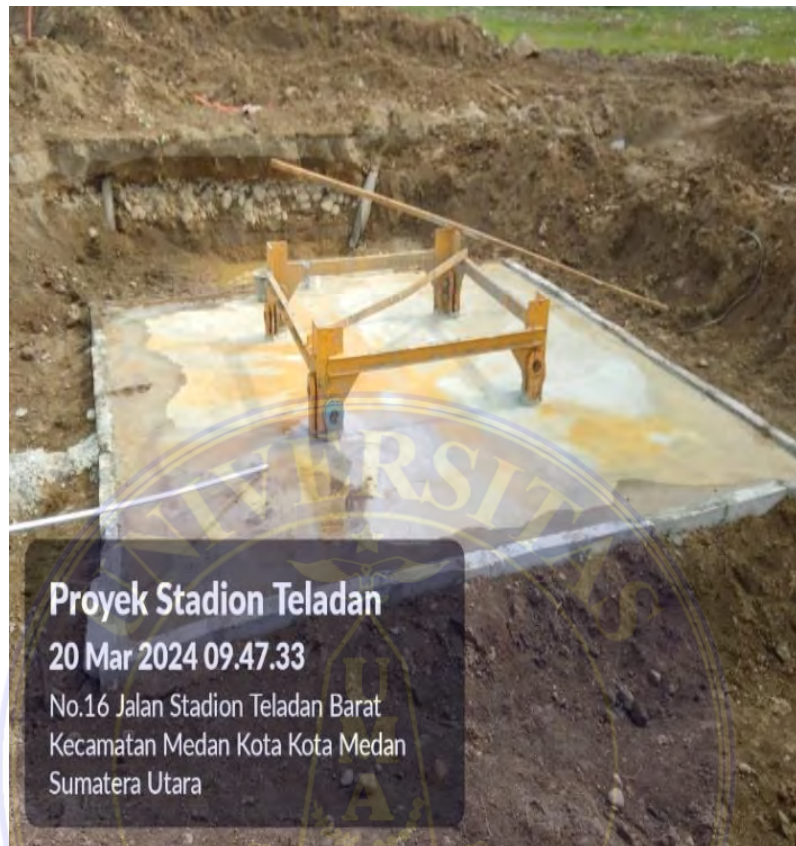
Gambar. Proses Pengeringan Beton
