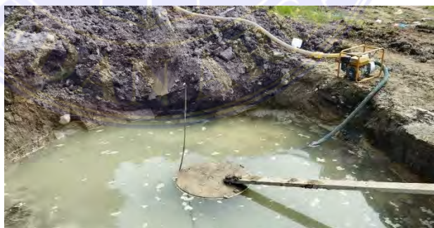
Gambar 4.5 Pasang Pompa
