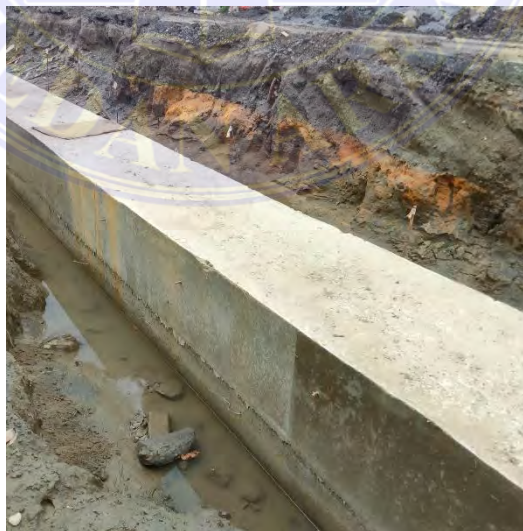
Gambar 4. 8 Pembongkaran dan Curing Capping Beam
