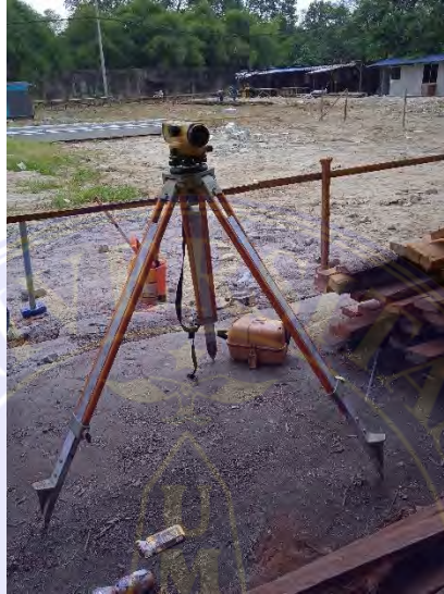
Gambar 3.4 Waterpass Sumber: Dokumentasi Proyek
