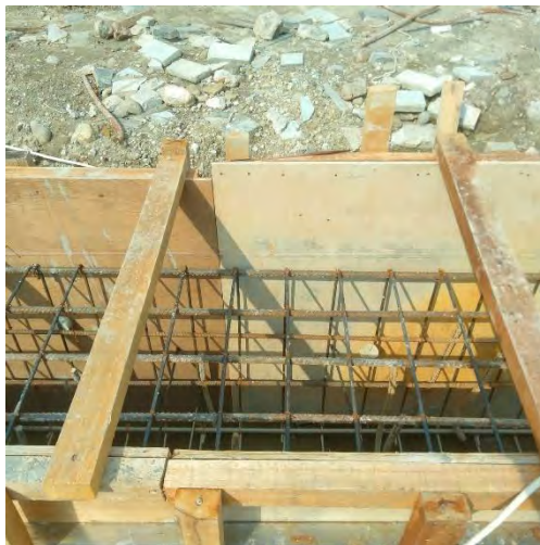
Gambar 4.6 Pemasangan Bekisting
