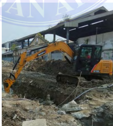
Gambar 4.4 Pembobokan Kepala Secant Pile
