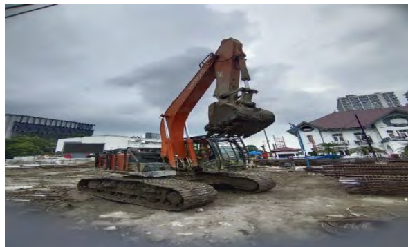
Gambar 3.5 Excavator Sumber: Dokumentasi Proyek
