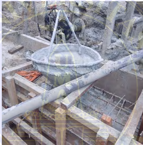
Gambar 3. 15 Beton Rady Mix Sumber: Dokumentasi Proyek
