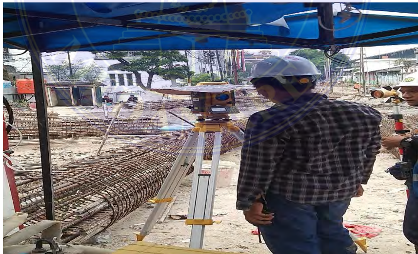
Gambar 3.1 Total Station Sumber: Dokumentasi Proyek
