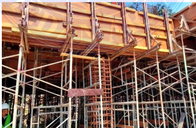
Gambar 3.1.9 Bekisting (Kolom dan Balok) Sumber : Lampiran Lapangan
