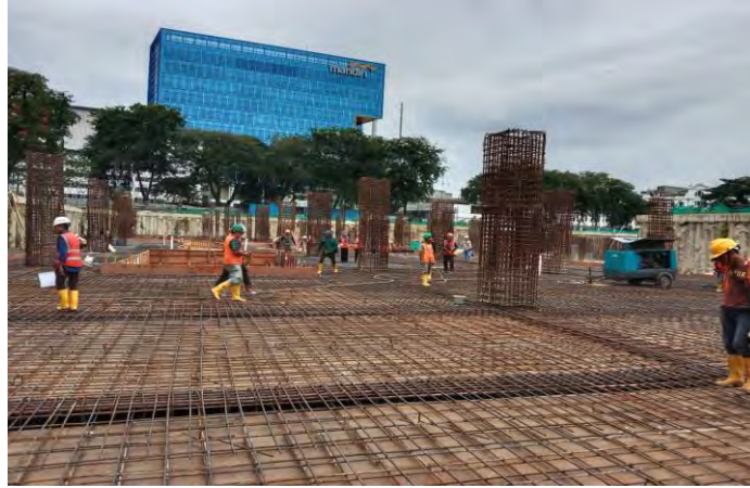
Gambar 4.3.4 Pemasangan Tulangan Sumber : Data Lapangan
