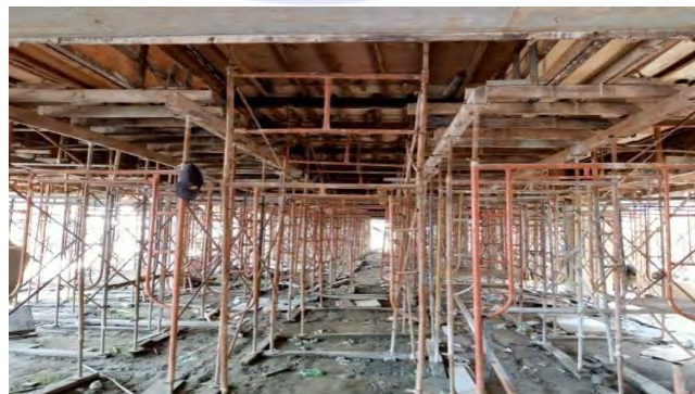
Gambar 4.3.2 Pemasangan Scaffolding . Sumber : Data lapangan
