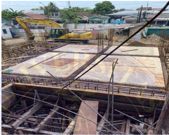
Gambar 4.3.3 Pemasangan Bekisting Sumber : Data Lapangan
