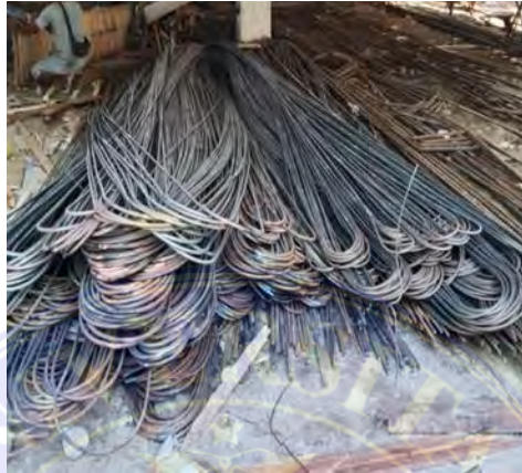
Gambar 3.2.2 Besi Tulangan Sumber : Lampiran Lapangan
