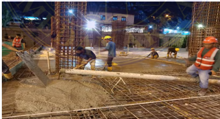
Gambar 4.3.5 Pengecoran Plat Lantai Sumber : Data Lapangan
