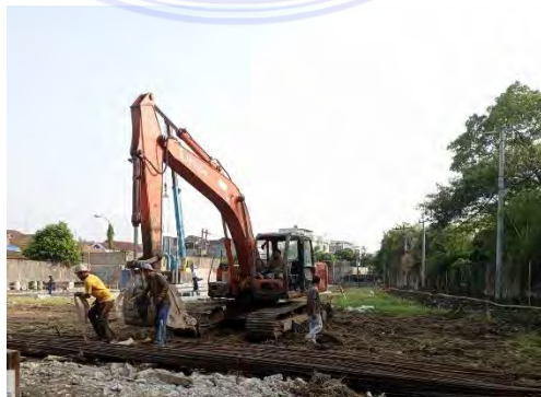
Gambar 3.1.5 Excavator Sumber : Lampiran Lapangan
