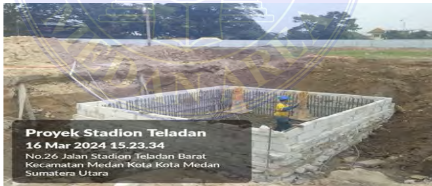
Gambar 47 Pemasangan lantai kerja
