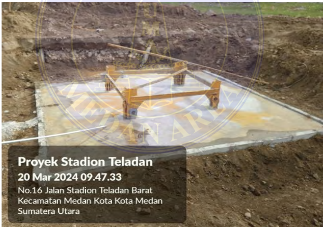
Gambar proses pengeringan beton
