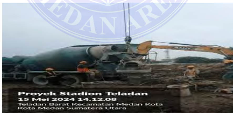
Gambar 49 pengecoran
