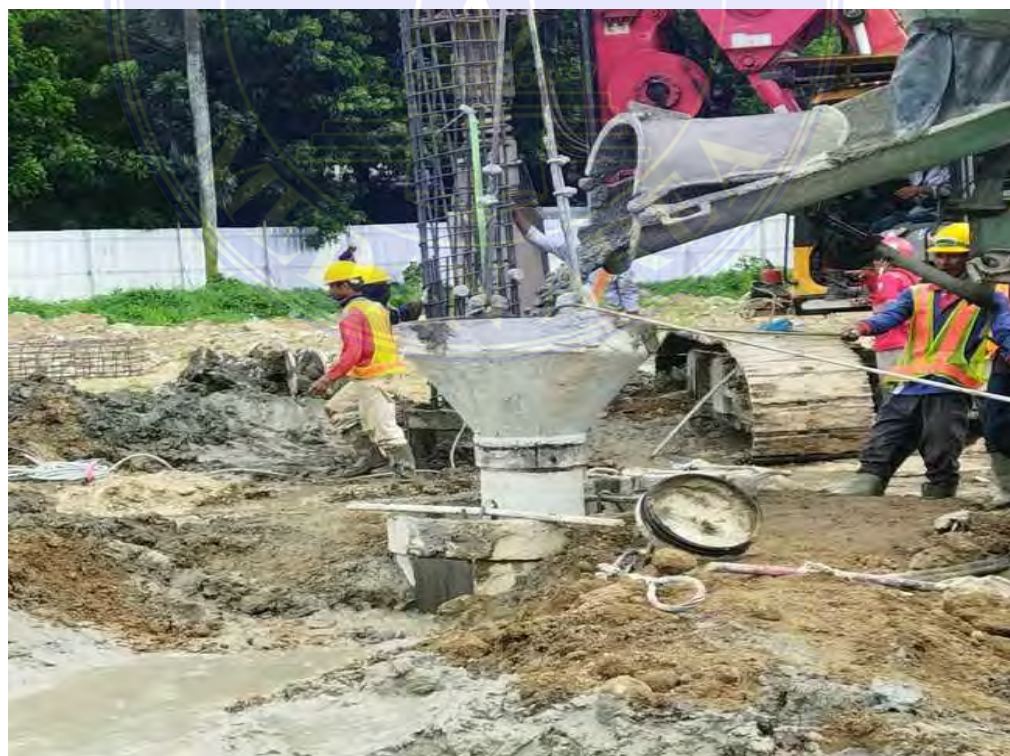
Gambar. Proses Pengecoran
