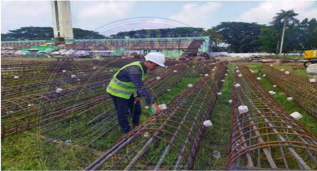
Gambar pengukuran jarak beton dacking Gambar penginstalan kesing ke lubang bp
