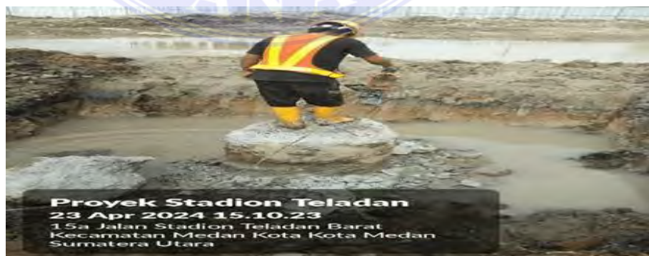
Gambar 45 Pembobotan bore pile
