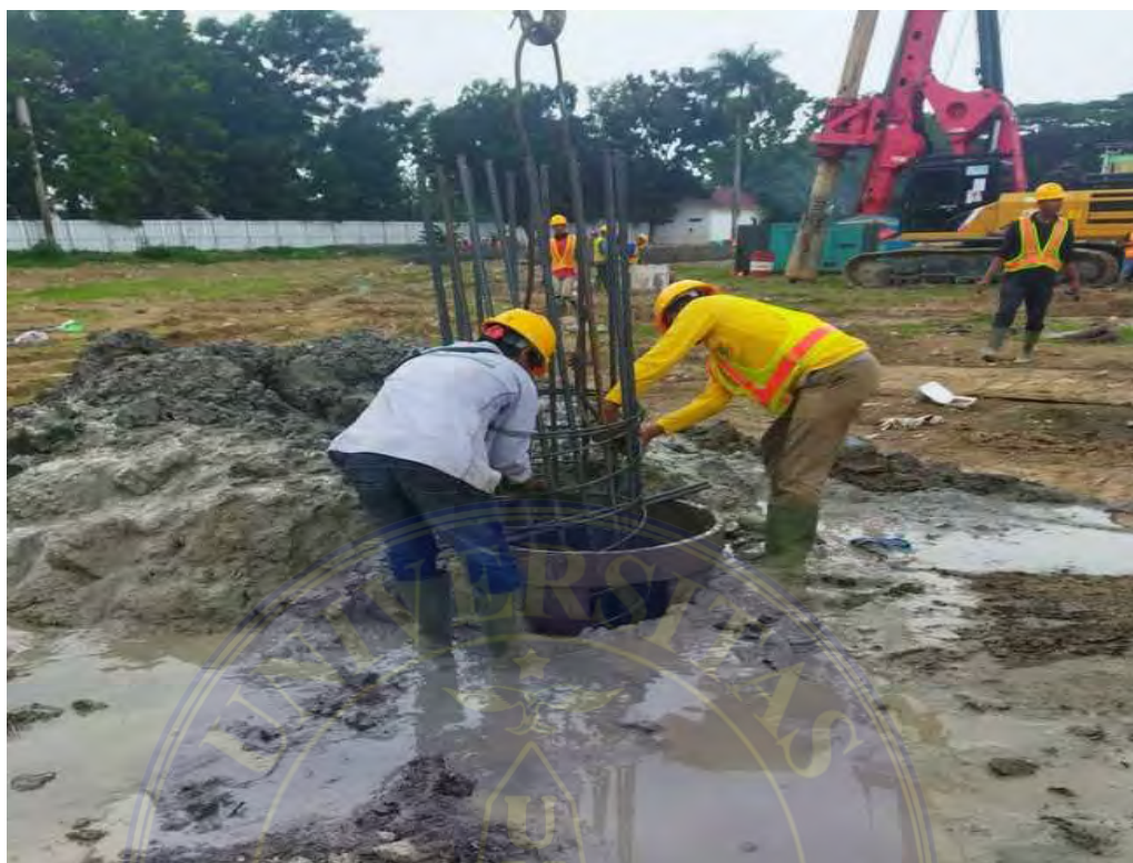
Gambar. Instal Besi
