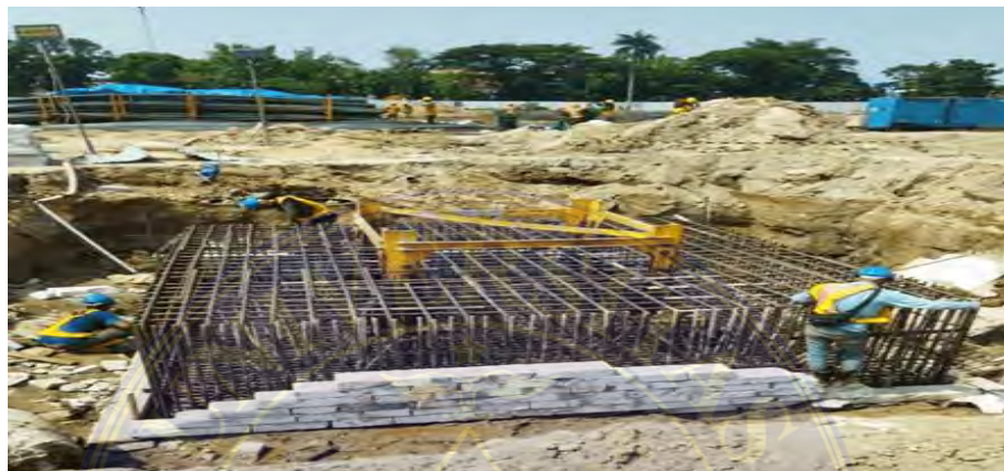
Gambar 48 Penulangan pile cap
