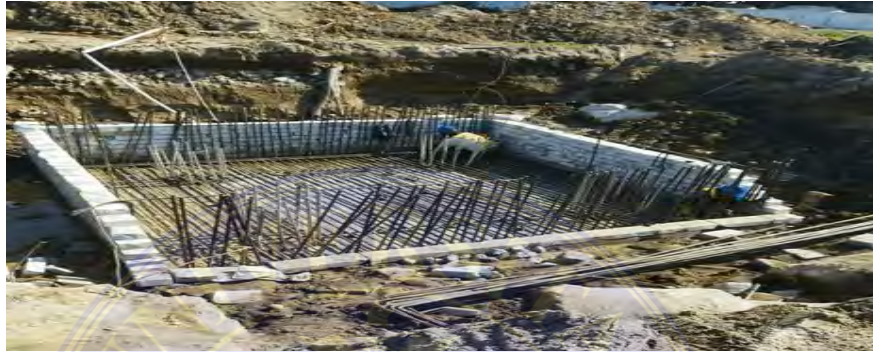
Gambar 46 pemasangan bekisting
