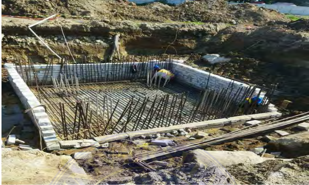
Gambar. Proses Penulangan dan Bekisting
