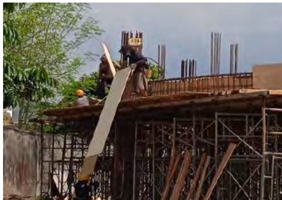
Gambar 4.7 Pembuatan Bekisting Balok Sumber : Data Lapangan
