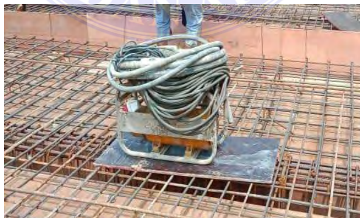
Gambar 3.3 Beton Vibrator Sumber : Data Lapangan
