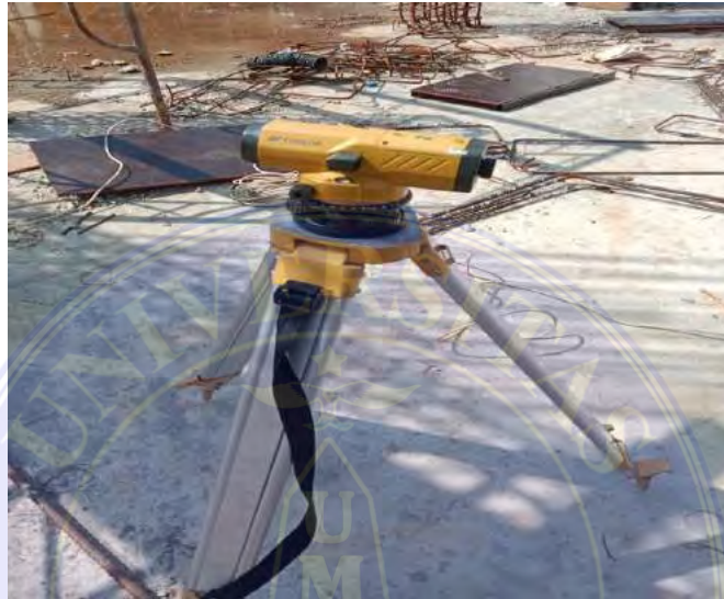
Gambar 3.4 Waterpass Sumber : Data Lapangan
