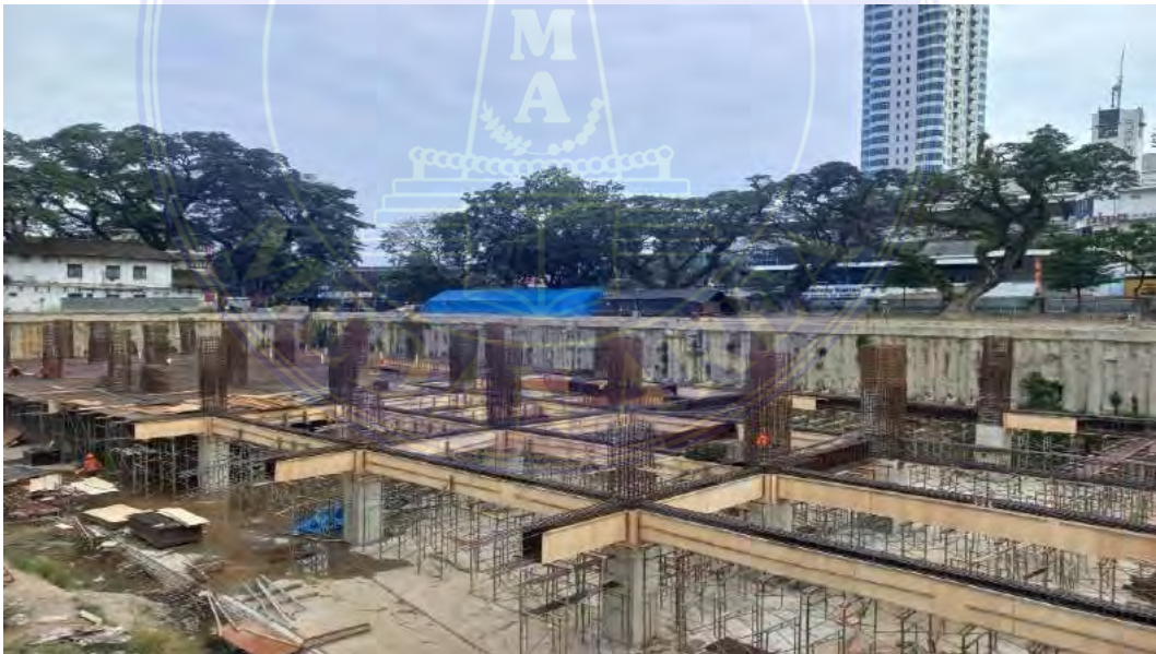
Gambar: Pembuatan Bekisting Balok
