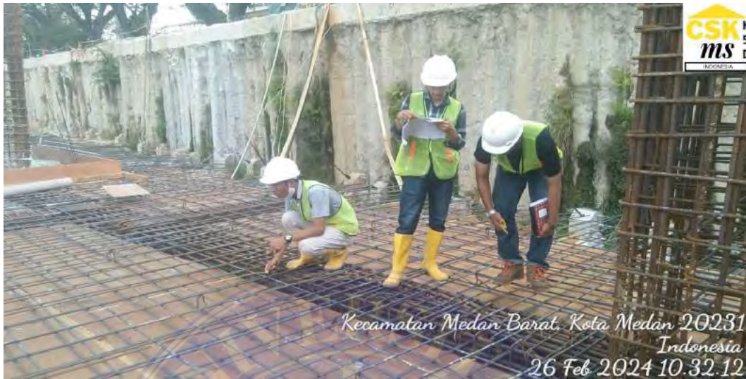
Gambar: Pengecekan Penulangan Balok
