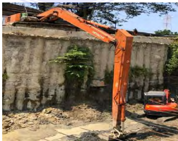
Gambar 3.5 Excavator Sumber : Data Lapangan
