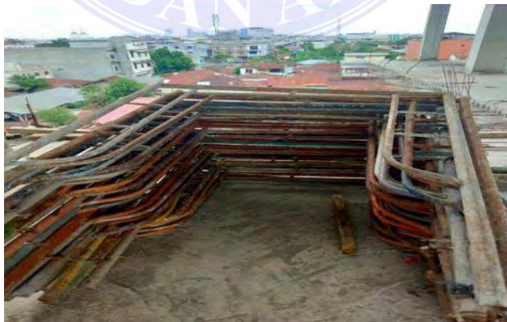
Gambar 3.27 Scaffolding Sumber : Data Lapangan
