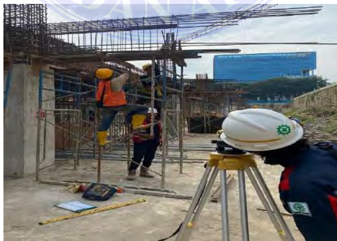
Gambar 4.6 Penentuan Elevasi Balok Sumber : Data Lapangan
