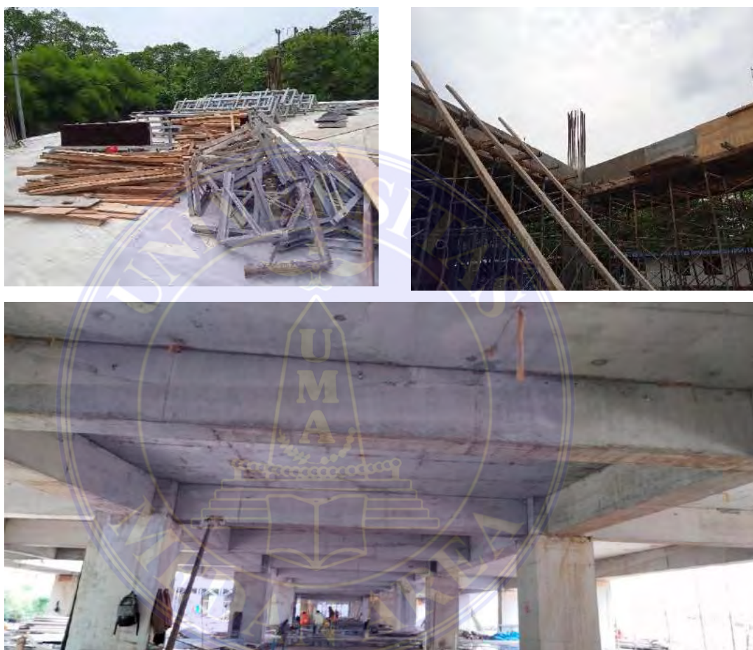
Gambar 4.10 Pelepasan Bekisting Balok Sumber : Data Lapangan
