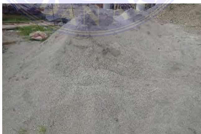
Gambar 3.37 Pasir Beton Sumber : Data Lapangan
