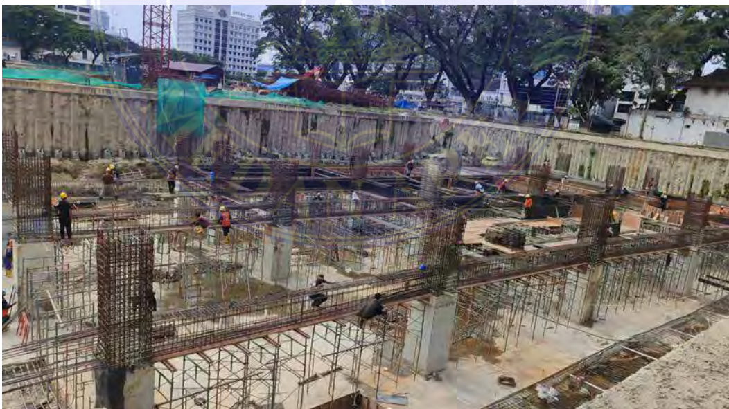
Gambar: Penulangan Balok
