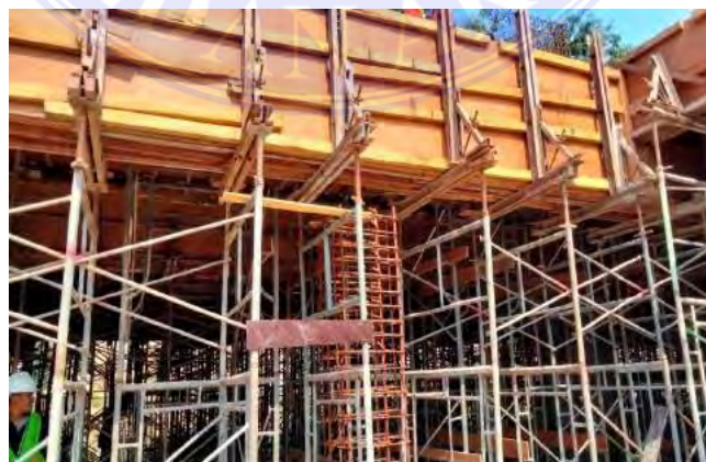
Gambar 3.9 Bekisting ( Balok) Sumber : Data Lapangan
