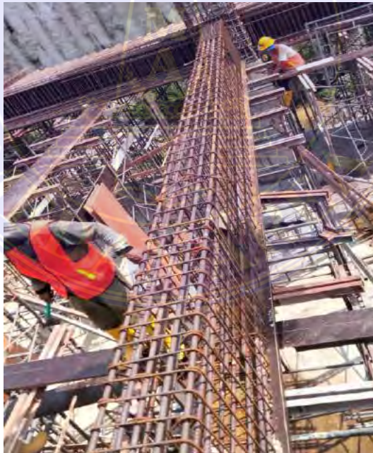
Gambar 4.8 Penulangan Balok Sumber : Data Lapangan
