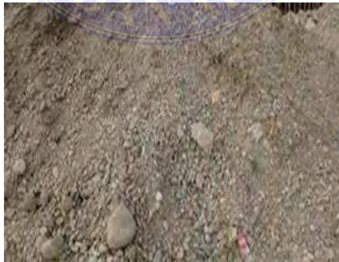
Gambar 3.39 Tanah Timbunan Sumber : Data Lapangan
