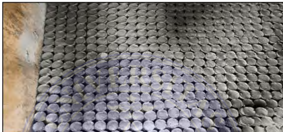
Gambar 3.43 Beton Decking Sumber : Dokumentasi Lapangan
