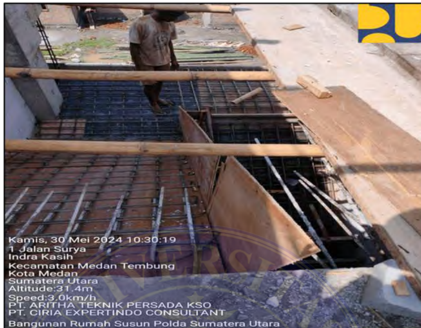
Gambar 3 Pemasangan penulangan Tangga
