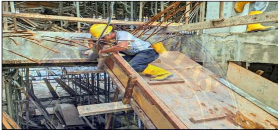
Gambar 4.3 Pemasangan Bekisting Tangga
