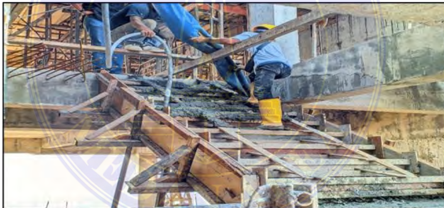
Gambar 4.5 Pengecoran Tangga
