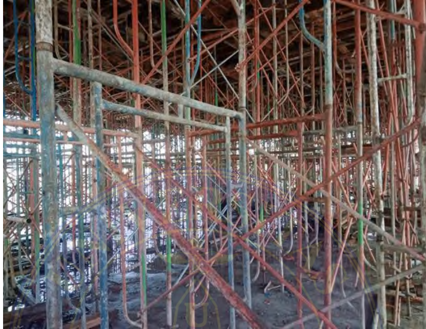
Gambar 1 Pemasangan Scaffolding Sumber: Dokumentasi Lapangan
