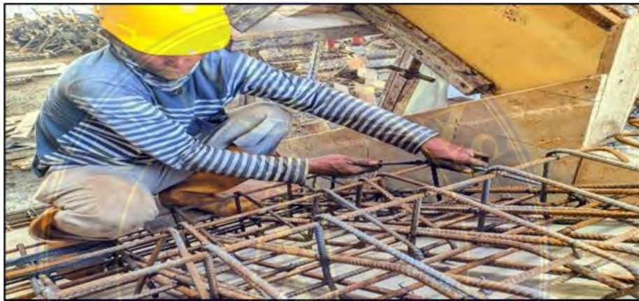
Gambar 4.4 Pemasangan Penulangan Tangga
