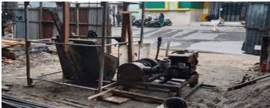
Gambar 3.30 Bucket Cor Sumber : Dokumentasi Lapangan
