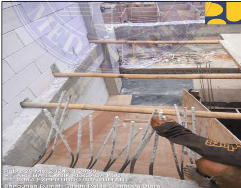
Gambar 2 Pemasangan bekisting Tangga Sumber : Data Lapangan
