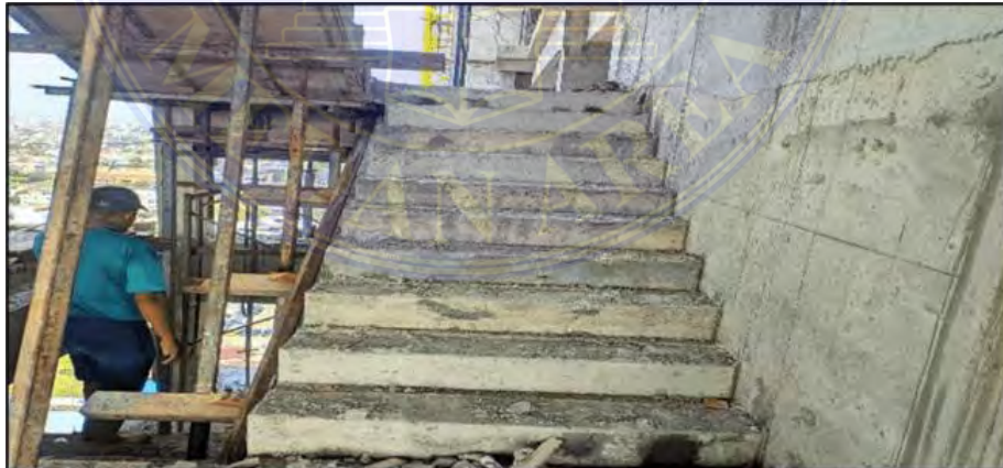
Gambar 4.6 Pembongkaran Bekisting Tangga
