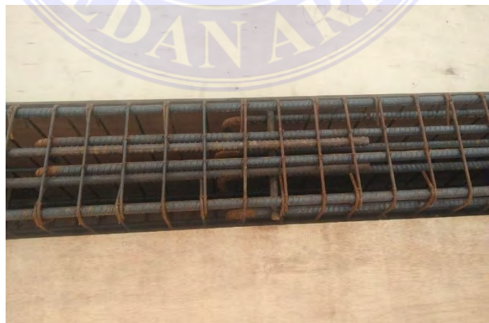
Gambar 4.3.6 Gambar Pembesian pada Balok
