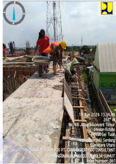
Gambar 2. Pengecoran
