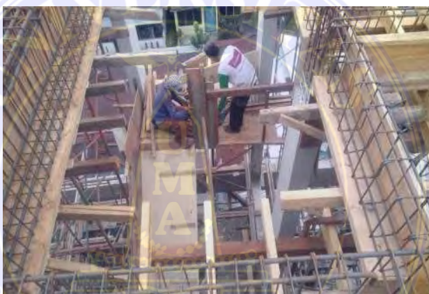
Gambar 4.3.8 Pemasangan Bekisting Balok
