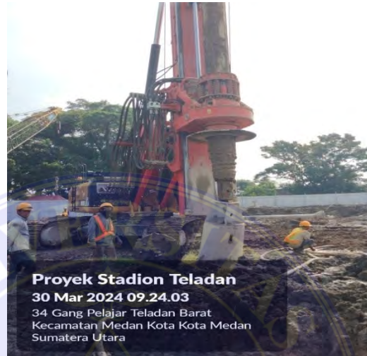
Gambar 3.1.16 Alat berat Bore pile (Dokumentasi Proyek)
