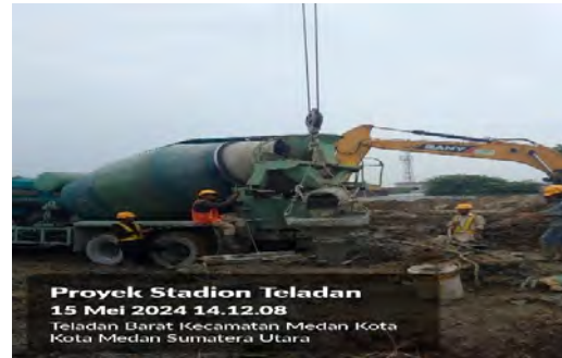
Gambar 3.1.10 Truck Mixer Beton (Dokumentasi Proyek)
