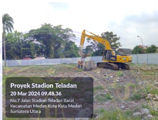
Gambar 3.1.5 Excavator (Dokumentasi Proyek)
