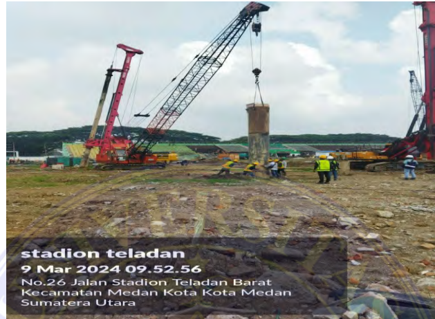
Gambar 4.2.6 Pemasangan casing
