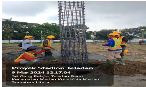
Gambar 4.2.10 Pemasangan besi
