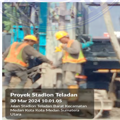
Gambar 4.2.9 Pengecekan Kedalaman pengeboran
