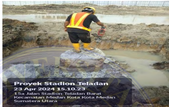
Gambar 3.1.9 Jack Hammer (Dokumentasi Proyek)
