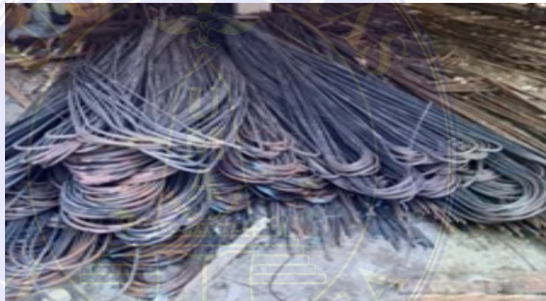
Gambar 3.2.2 Besi Tulangan (Dokumentasi Proyek)
