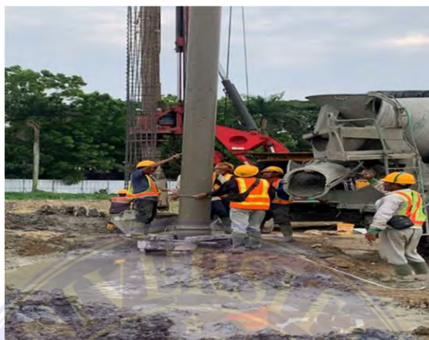
Gambar 4.2.14 Pengangkatan Pipa Tremi
