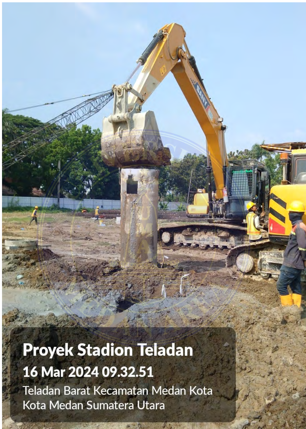
Gambar: Pemasangan Temporary casing
