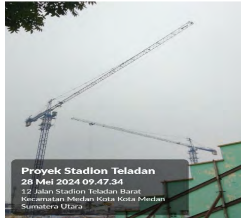
Gambar 3.1.17 Tower Crane (Dokumentasi Proyek)
