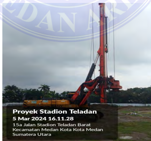
Gambar 4.2.4 Vertikality alat bor
