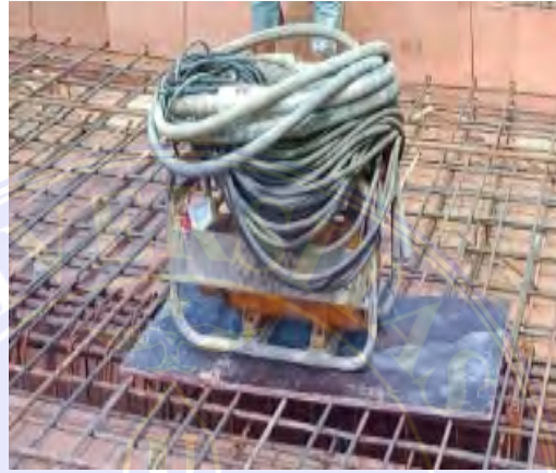
Gambar 3.1.3 Vibrator Concrete (Dokumentasi Proyek)
