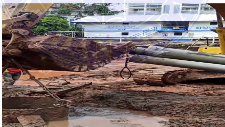
Gambar 4.2.15 Pengangkatan Temporary casing
