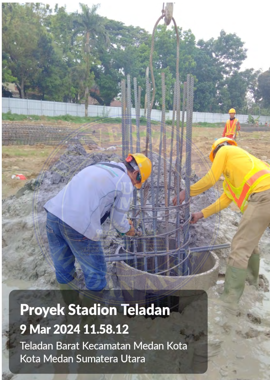
Gambar: Penyambungan besi tulangan
