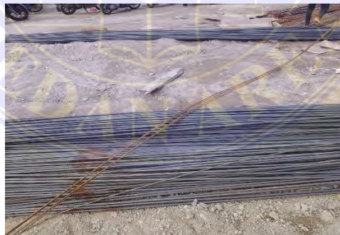
Gambar 3.34 Besi Tulangan Sumber : Dokumentasi Proyek, 2024
