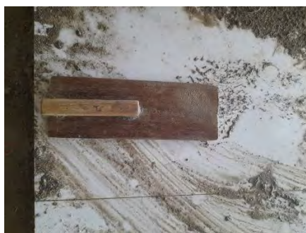
Gambar 3.19 Raskam Sumber : Dokumentasi Proyek, 2024
