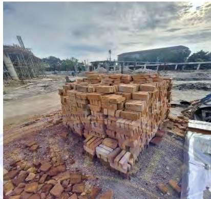
Gambar 3.41 Batu Bata Sumber : Dokumentasi Proyek, 2024
