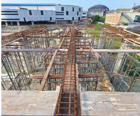
Gambar 4.4 Pemasangan Tapak Balok Sumber : Dokumentasi Proyek, 2024
