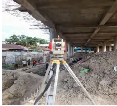
Gambar 3.7 Theodolite Sumber : Dokumentasi Proyek, 2024
