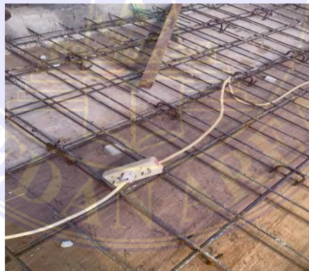
Gambar 3.26 Cok Sambung Sumber : Dokumentasi Proyek, 2024
