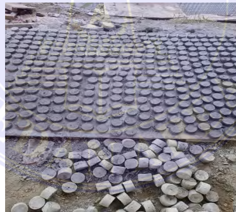
Gambar 3.40 Beton Decking Sumber : Dokumentasi Proyek, 2024
