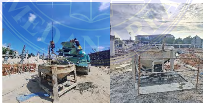
Gambar 3.12 Bucket Cor Sumber : Dokumentasi Proyek, 2024
