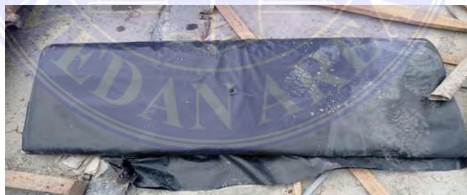
Gambar 3.42 Plastik Cor Sumber : Dokumentasi Proyek, 2024
