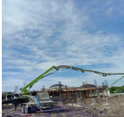
Gambar 3.11 Concrete Pump Sumber : Dokumentasi Proyek, 2024
