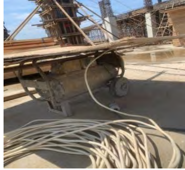
Gambar 3.5 Mesin Vibrator Sumber : Dokumentasi Proyek, 2024
