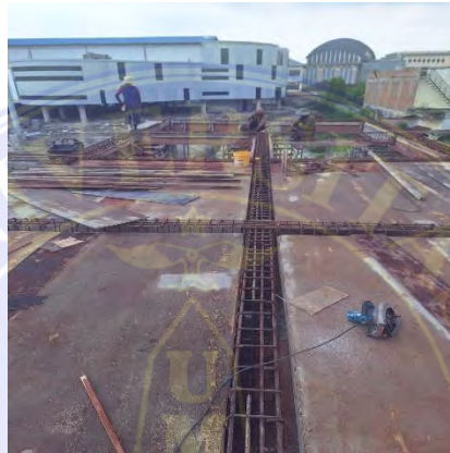
Gambar 4.3 Proses Pembuatan Bekisting Sumber : Dokumentasi Proyek, 2024
