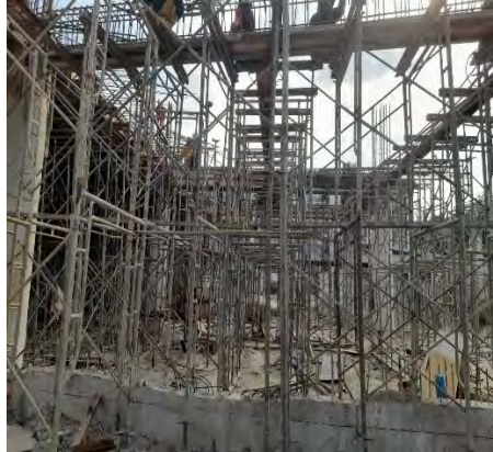
Gambar 3.23 Scaffolding Sumber : Dokumentasi Proyek, 2024
