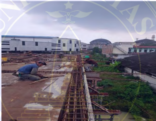
Gambar 4.5 Pemasangan Bekisting Balok Sumber : Dokumentasi Proyek, 2024
