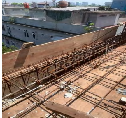
Gambar 3.9 Bekisting Sumber : Dokumentasi Proyek, 2024
