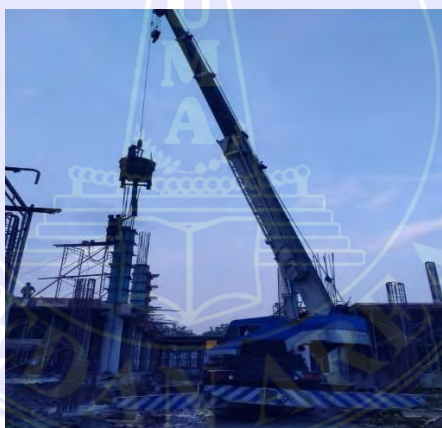
Gambar 3.16 Rough Terrain Crane Sumber : Dokumentasi Proyek, 2024
