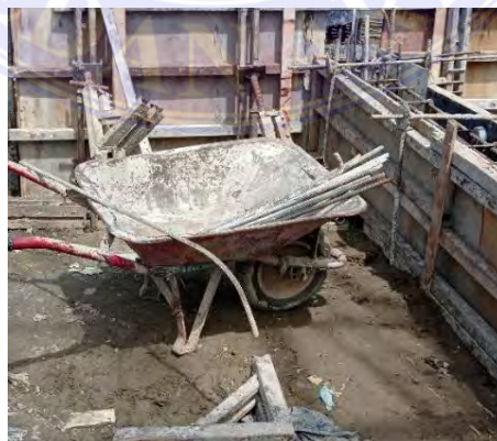
Gambar 3. 17 Kereta Sorong Sumber : Data Lapangan
