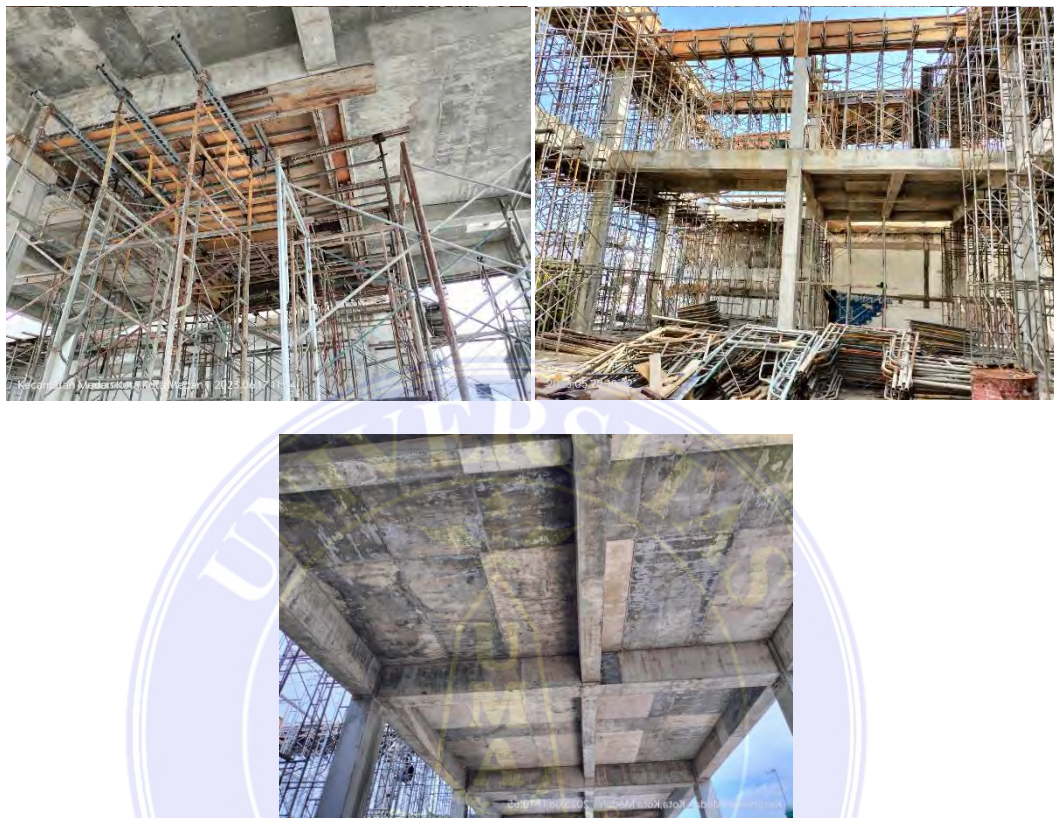
Gambar 4. 7 Pelepasan Bekisting Balok Sumber : Data Lapangan
