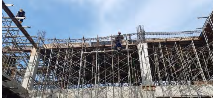
Gambar 4. 5 Penulangan Balok
