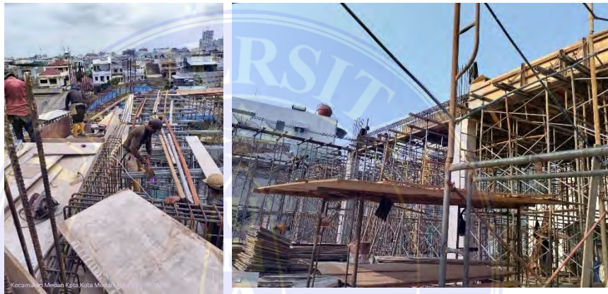
Gambar 4. 4 Pembuatan Bekisting Balok Sumber : Data Lapangan
