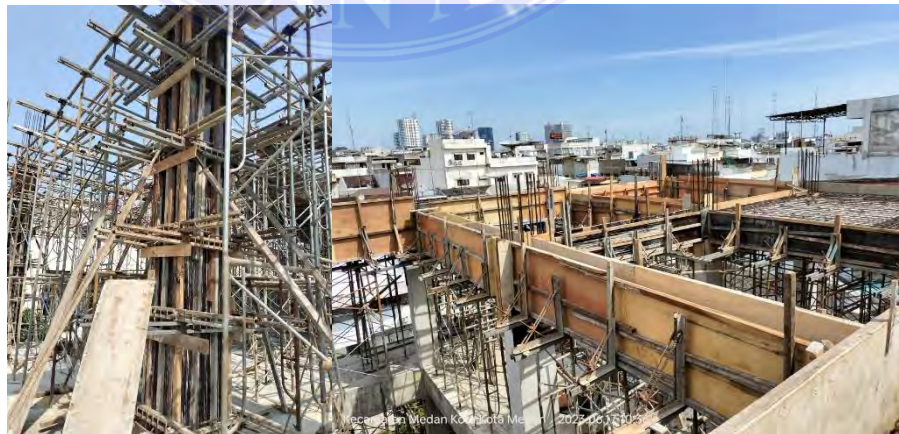
Gambar 3. 9 Bekisting(Kolom dan Balok) Sumber : Data Lapangan
