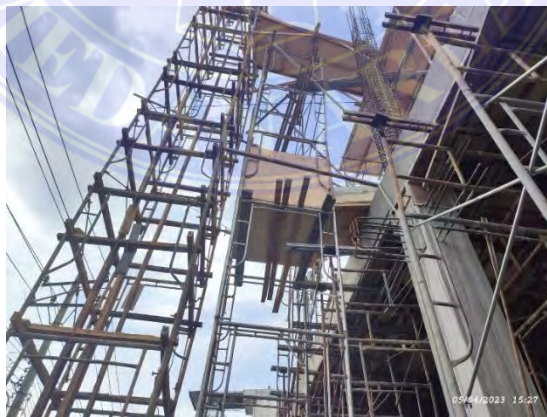
Gambar 3. 34 Lift Beton Sumber : Data Lapangan
