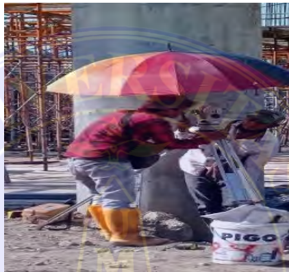
Gambar 4. 3 Penentuan Elevasi Balok Sumber : Data Lapangan
