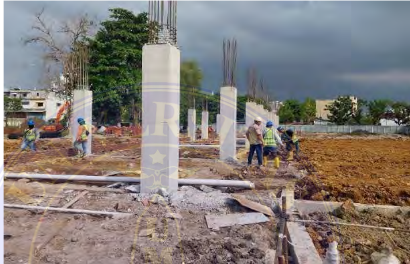
Gambar 4.9 Tahap Perawatan Kolom sumber : Dokumentasi lapangan
