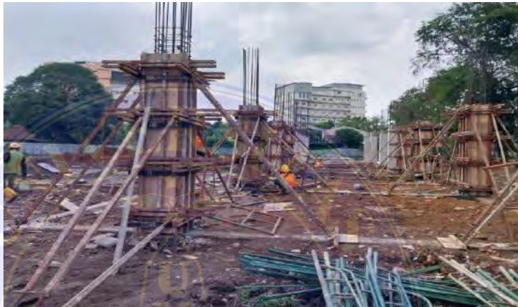
Gambar 4.7 Pemasangan Bekisting sumber : Dokumentasi lapangan
