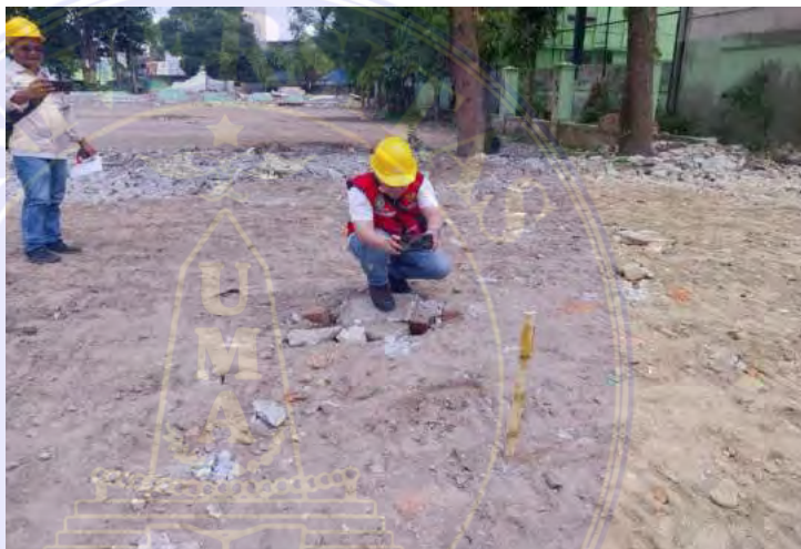
Gambar 4.4 Penentuan titik as kolom sumber : Dokumentasi Lapangan
