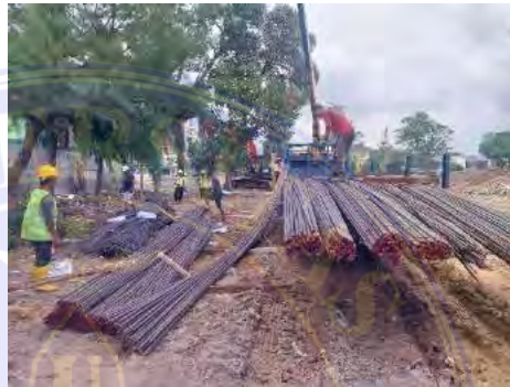
Gambar 3.16 Besi Ulir sumber : dokumentasi lapangan
