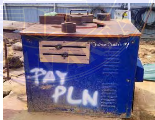
Gambar 3.5 Bar Bending sumber : dokumentasi lapangan
