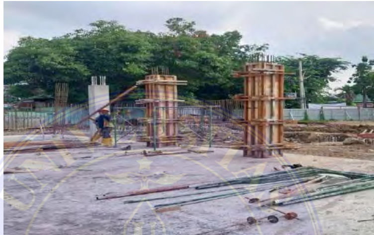
Gambar 4.8 Pembongkaran Bekisting
