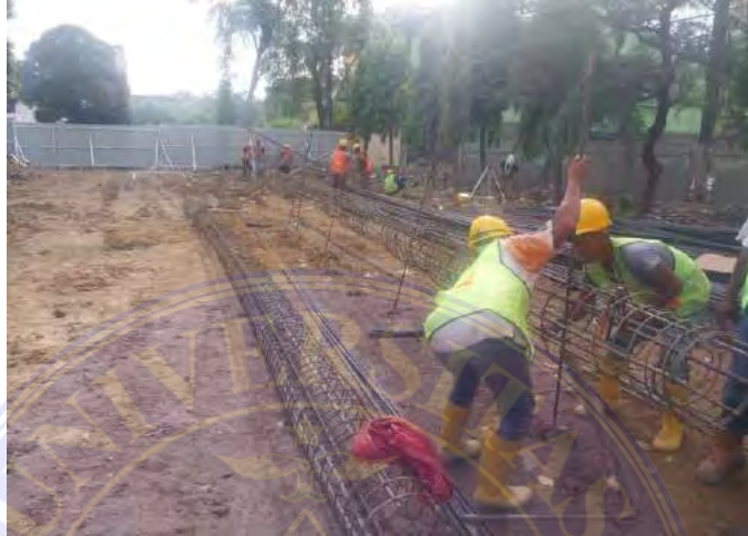
Gambar 4.6 Tahap Pembesian sumber : Dokumentasi lapangan
