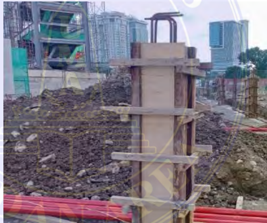
Gambar 3.12 Bekisting sumber : dokumentasi lapangan
