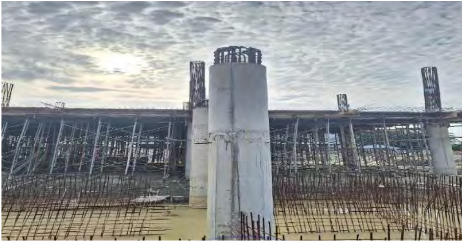
Gambar 4.12. Kolom yang sudah, Sumber : Dokumentasi Proyek 2024
