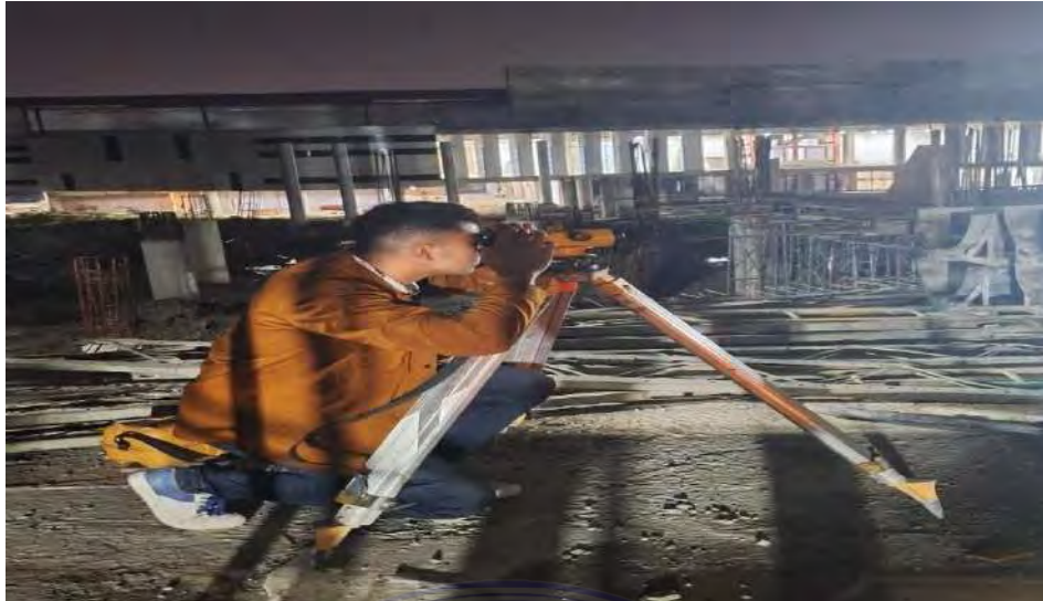
Gambar 3. Penggunaan Waterpass Sumber : Dokumentasi Proyek 2024
