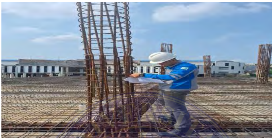
Gambar 4.5. Perakitan tulangan kolom, Sumber : Dokumentasi Proyek 2024
