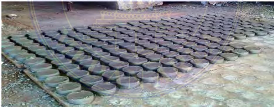
Gambar 4.4 Pembuatan beton decking,
