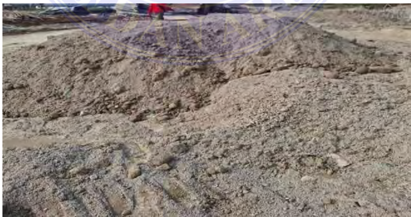
Gambar 2.26 Tanah Timbunan, Sumber: Dokumentasi Proyek 2024
