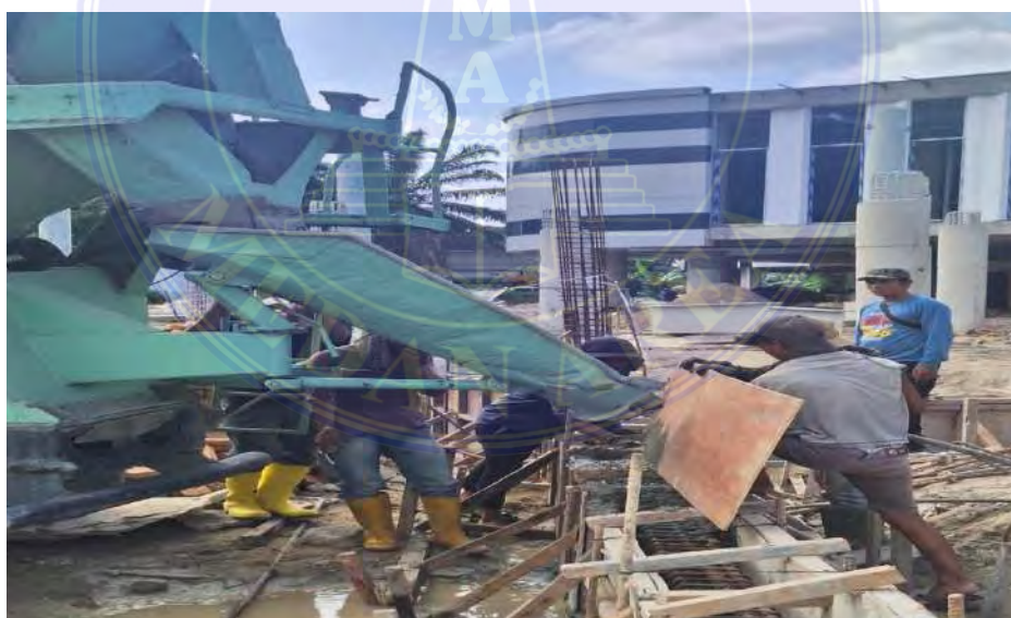
Gambar 6. Pengecoran Sloof
