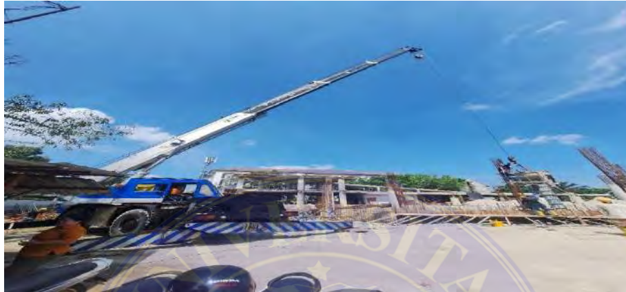
Gambar 3.17 Rough Terrain Crane , Sumber : Dokumentasi Proyek 2024
