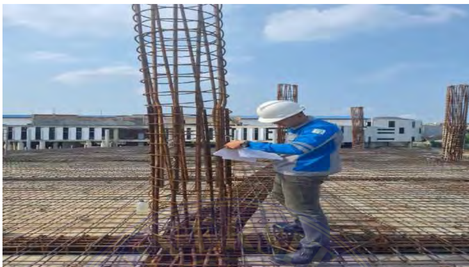
Gambar 1. Pengecekan Tulangan Kolom
