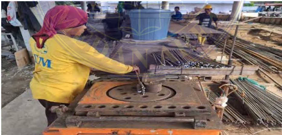
Gambar 4.2. Pembengkokan besi tulangan, Sumber: Dokumentasi Proyek 2024
