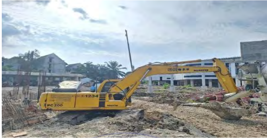
Gambar 3.3 Excavator , Sumber : Dokumentasi Proyek 2024
