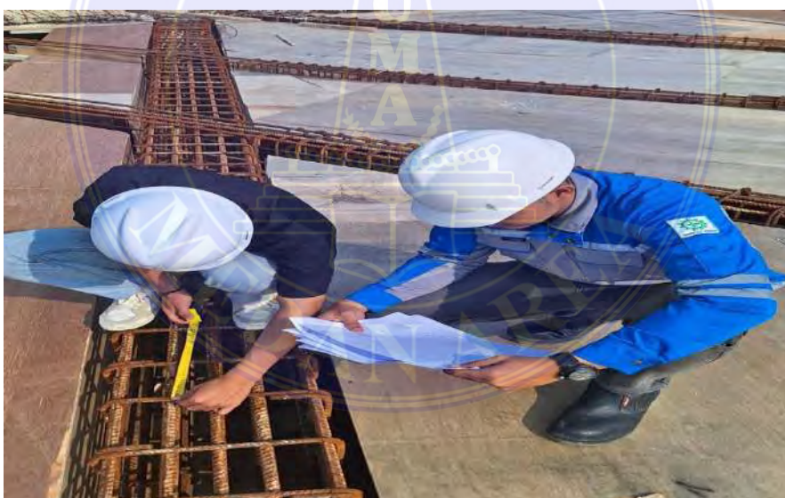
Gambar 8. Pengecekan Tulangan Balok
