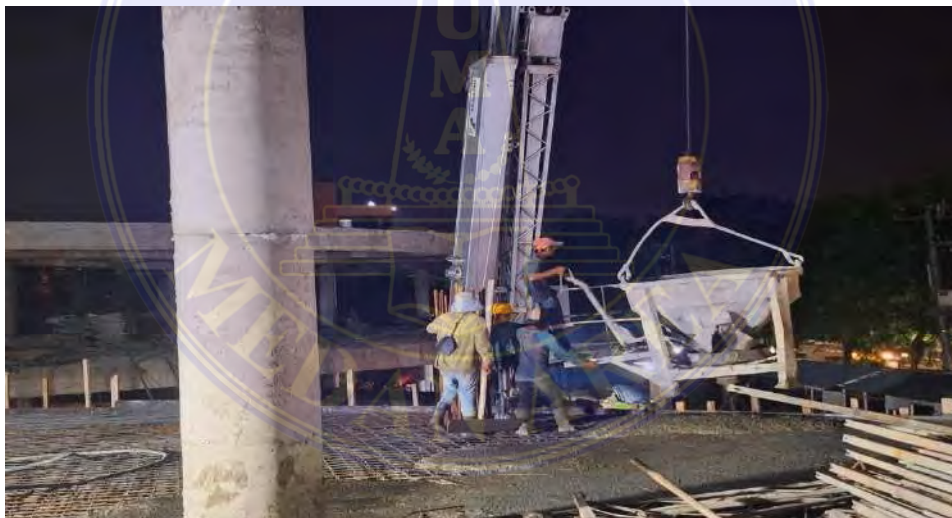
Gambar 4. Pengecoran Plat Lantai Sumber : Dokumentasi Proyek 2024
