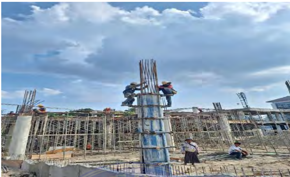
Gambar 7. Perakitan Tulangan Kolom
