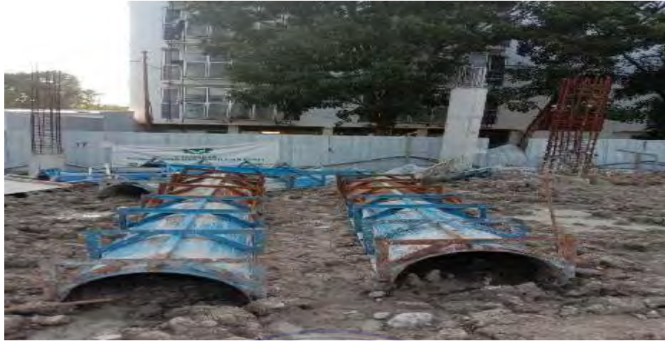
Gambar 4.3. Perakitan Bekisting ,
