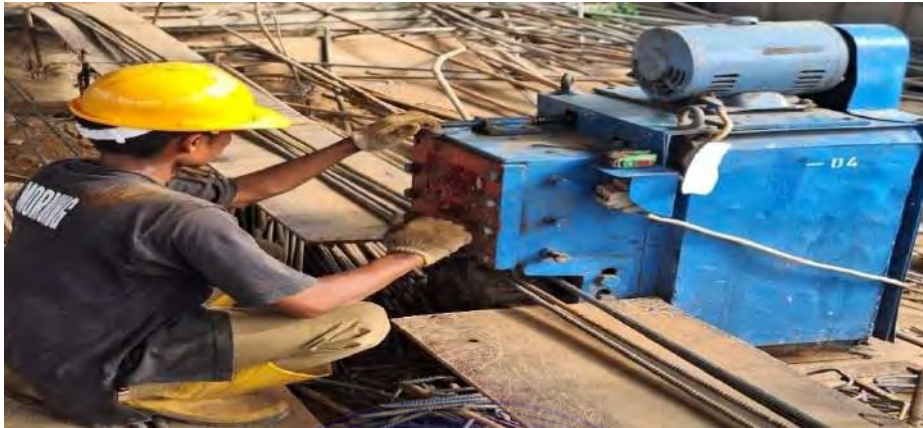
Gambar 4.1. Pemotongan besi tulangan, Sumber: Dokumentasi Proyek 2024
