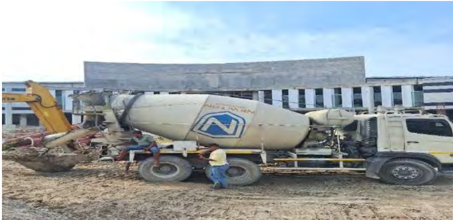
Gambar 3.6 Truck Mixer, Sumber : Dokumentasi Proyek 2024
