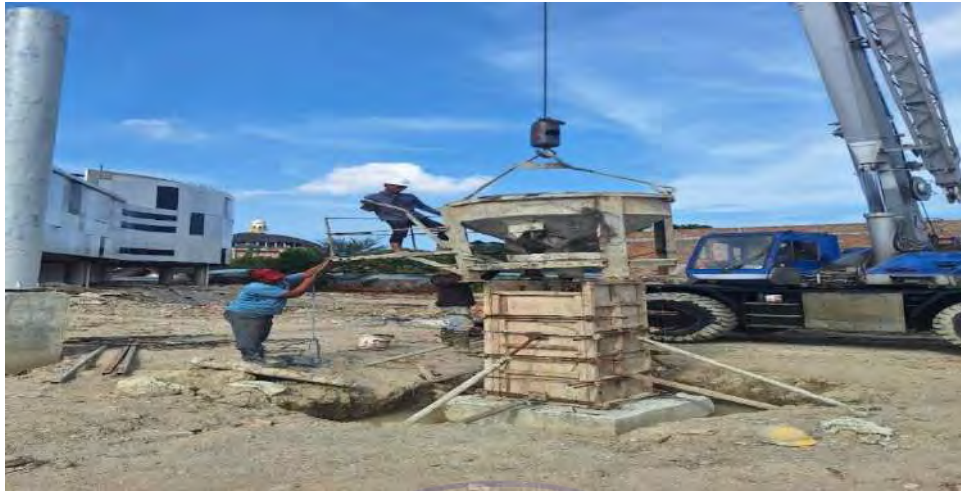
Gambar 4.11. Proses Pengecoran kolom,
