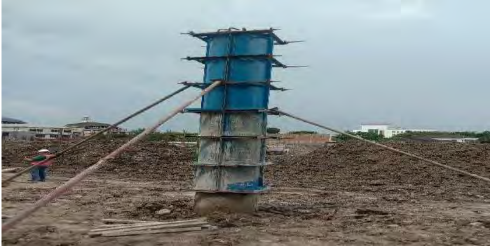
Gambar 4.8. Pemasangan penyangga
