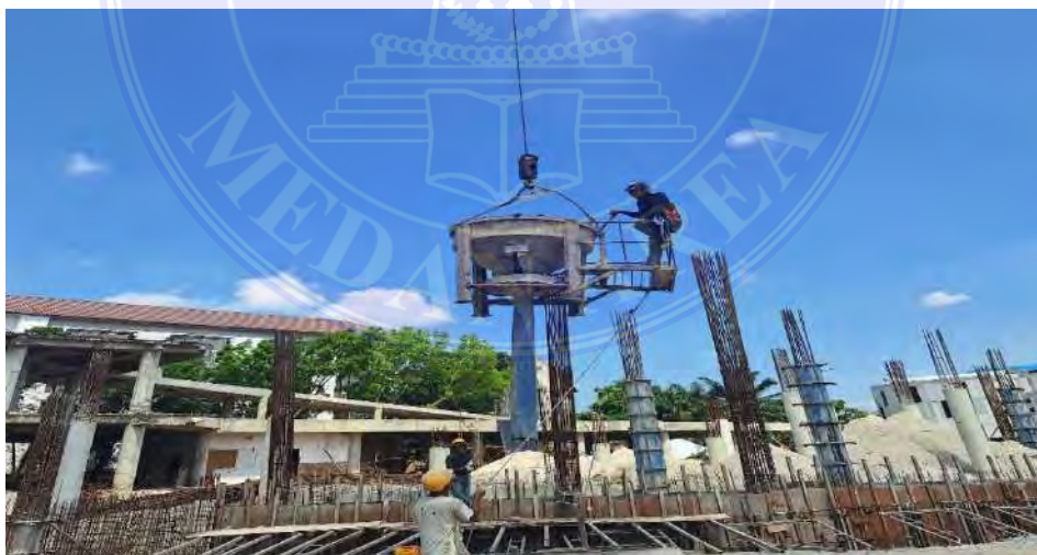
Gambar 2. Pengecoran Pada Kolom
