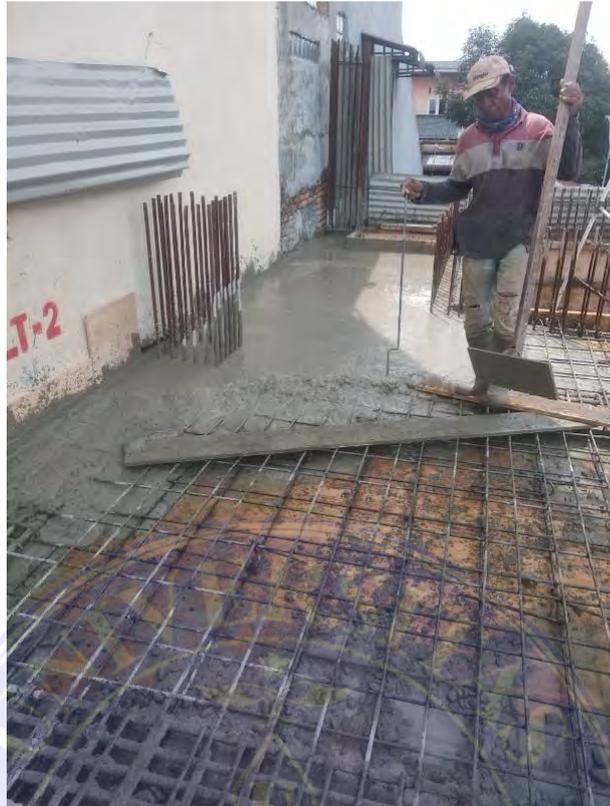
Gambar : Pengecoran Pelat Lantai
