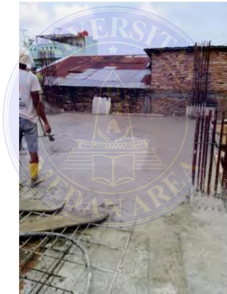
Gambar 4.5 Pengecoran Plat Lantai
