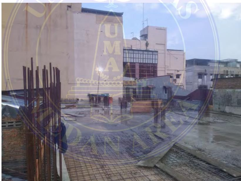
Gambar : Pengecoran Pelat Lantai
