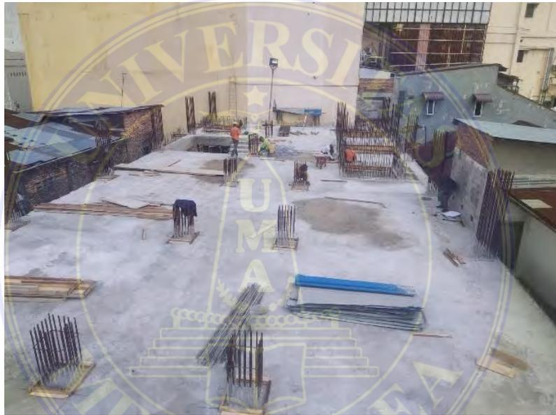
Gambar 4.6 Pekerjaan Pembongkaraan *Bekisting* Pelat Lantai
