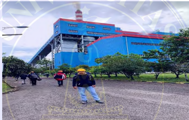
Dokumentasi Pengenalan Lingkungan Kerja Pabrik
