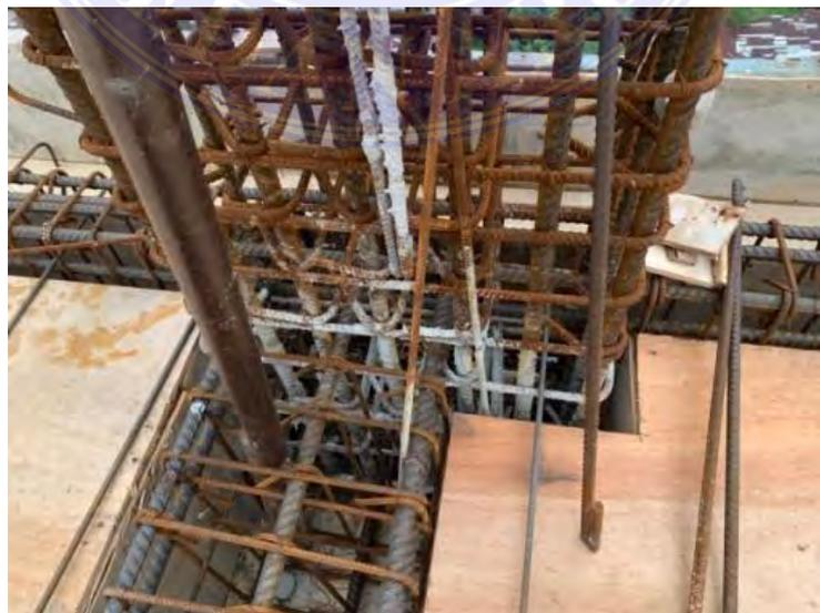
Gambar 3.30 Hubungan Penulangan antar balok dan kolom
