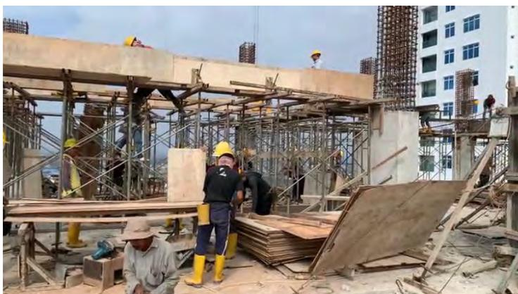
Gambar 3.20 Pemasangan Bekisting
