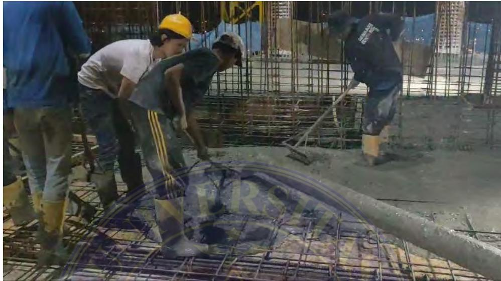
Gambar 3.27 Pengecoran
