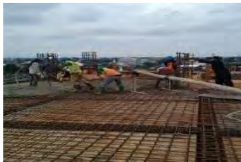
Gambar 3.9 Pengecoran Pelat Lantai & Balok
