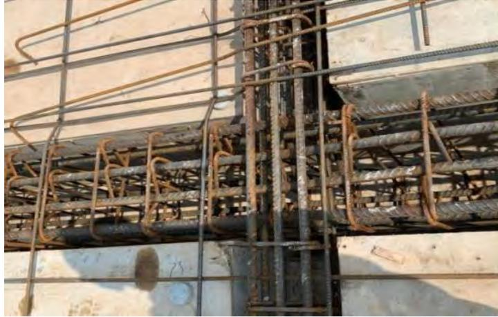
Gambar 3.29 Hubungan Penulangan antar Balok
