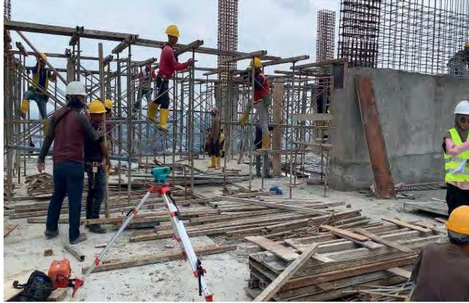
Gambar 3.18 Pekerjaan Survey dan Marking
