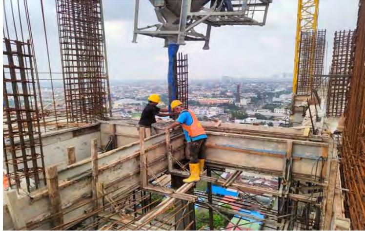
Gambar 3.12 Persiapan Pengecoran
