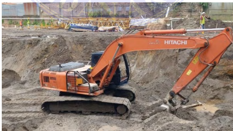
Gambar 3. 3 Excavator Sumber : Dokumentasi Lapangan
