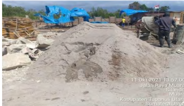
Gambar 3. 1 Agregat Halus Sumber : Dokumentasi Lapangan
