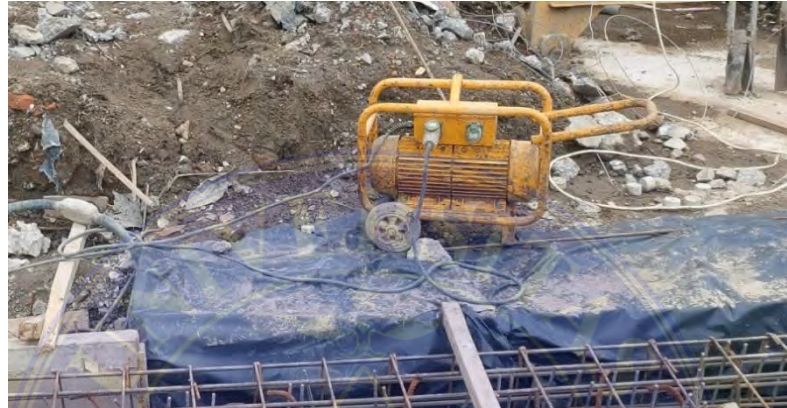
Gambar 3. 2 Vibrator Concrete Sumber : Dokumentasi Lapangan
