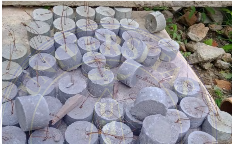
Gambar 3. 3 Beton Decking Sumber : Dokumentasi Lapangan
