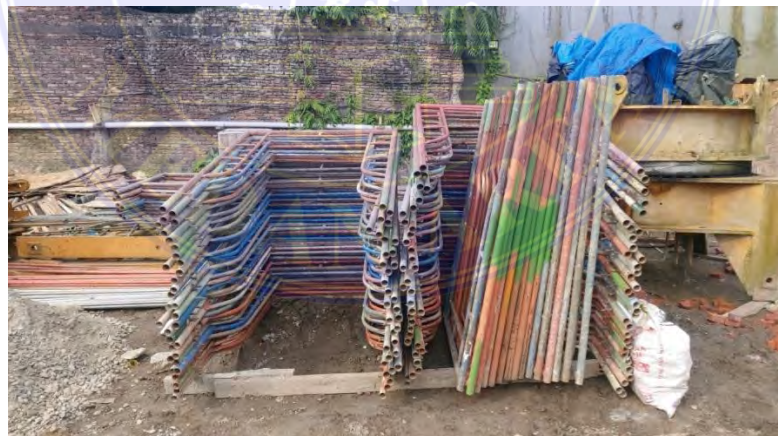
Gambar 3. 16 Scaffolding Sumber : Dokumentasi Lapangan
