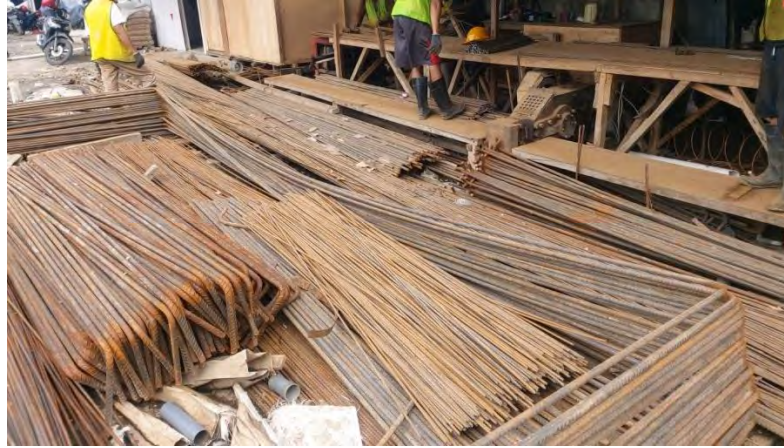
Gambar 3. 7 Baja Tulangan Sumber : Dokumentasi Lapangan
