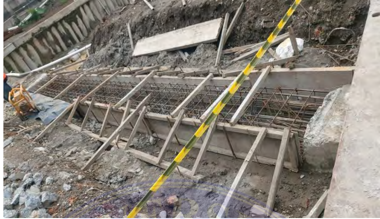
Gambar 3. 17 Bekisting Sumber : Dokumentasi Lapangan
