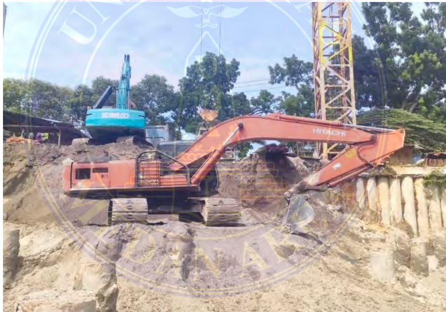
Gambar 4. 1 penggalian tanah Sumber : Dokumentasi Lapangan
