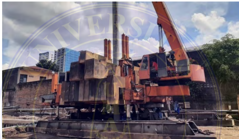
Gambar 3. 4 Hydraulic Static Pile Driver (HSPD) Sumber : Dokumentasi Lapangan
