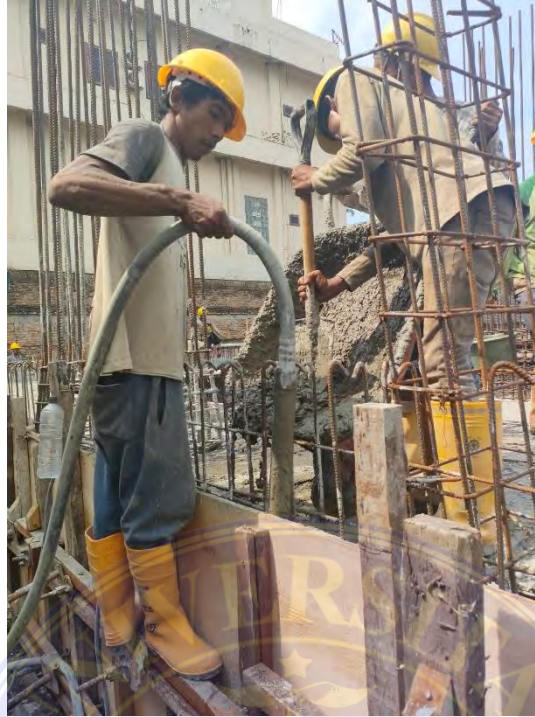
Gambar 4. 3 pengecoran plat lantai
