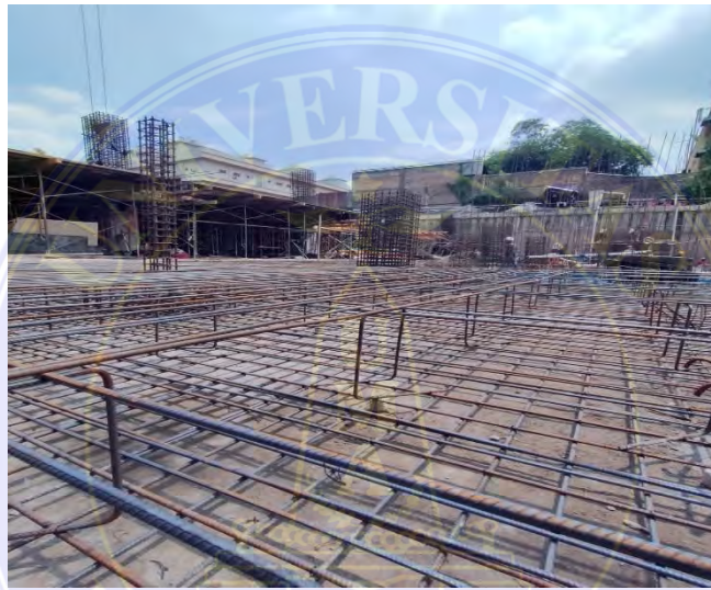
Gambar 4. 2 pembesian plat lantai
