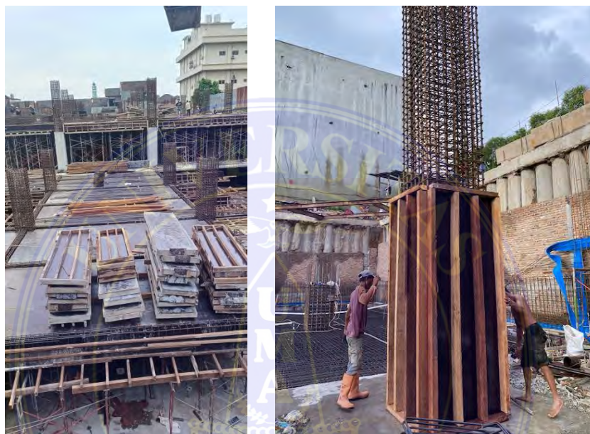
Gambar 3.3 Pembuatan Bekisting Sumber : Dokumentasi Lapangan
