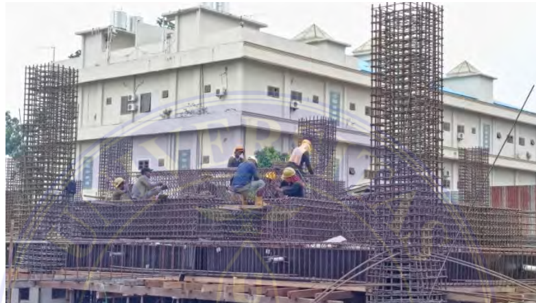
Gambar 3.4 Pembesian Kolom Sumber : Dokumentasi Lapangan
