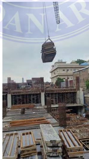
Gambar 2.9 Bekisting Sumber : Dokumentasi Lapangan
