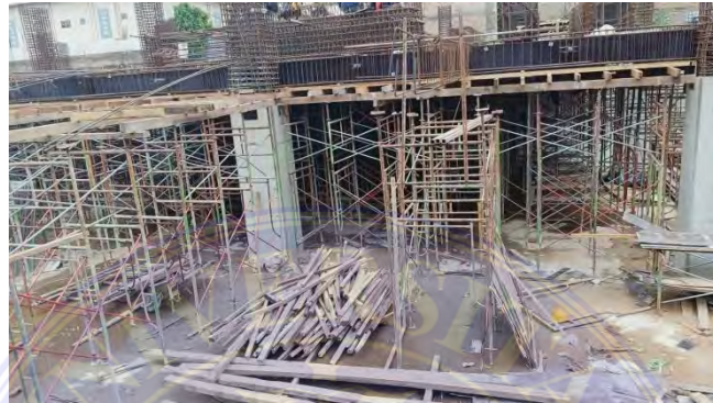
Gambar 2.8 Scaffolding Sumber : Dokumentasi Lapangan
