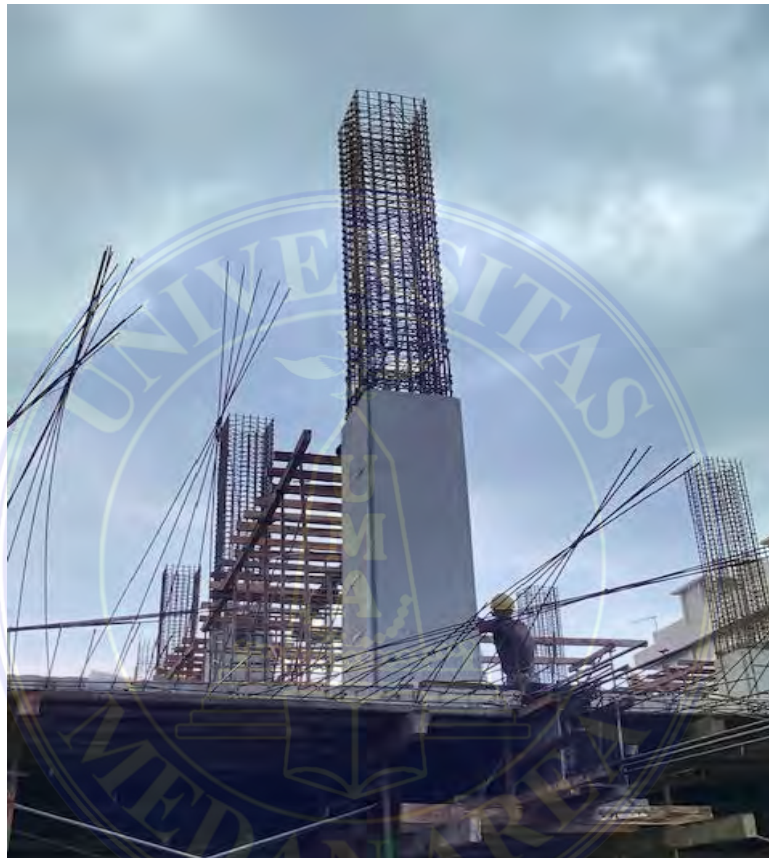
Gambar 3.6 Pembongkaran Bekisting Sumber : Dokumentasi Lapangan
