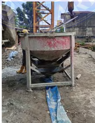
Gambar 2.7 Concrete Bucket Sumber : Dokumentasi Lapangan
