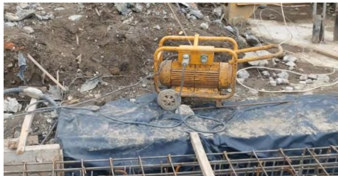
Gambar 2.3 Vibrator Concrete Sumber : Dokumentasi Lapangan
