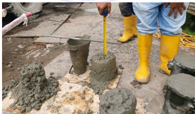
Gambar 2.13 Beton Ready Mix Sumber : Dokumentasi Lapangan
