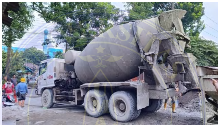
Gambar 2.2 Truck Mixer Concrete Sumber : Dokumentasi Lapangan
