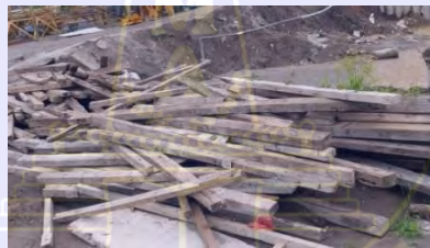
Gambar 2.17 Kayu Sumber : Dokumentasi Lapangan
