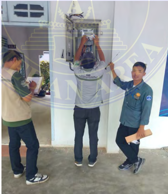
Proses pemeliharaan meteran dan modem tidak terbaca yang dilakukan oleh petugas resmi PT PLN (Persero) UP3 Medan Utara
