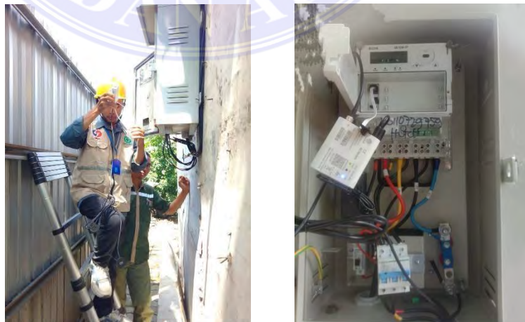
Gambar 3.2 : Pemasangam modem dan antena jaringan
