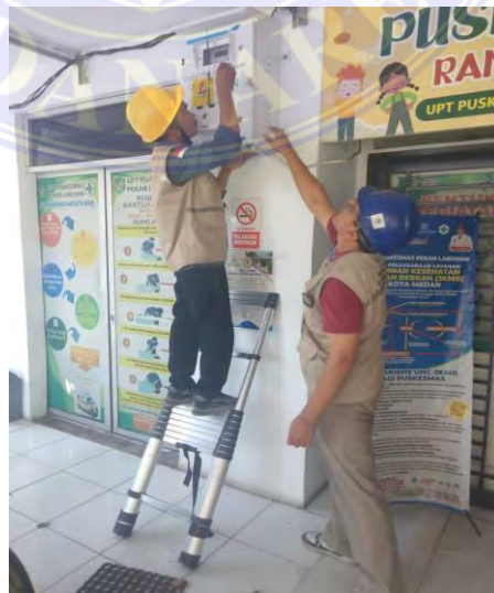
Gambar 3.4 : Pemasangan segel meteran
