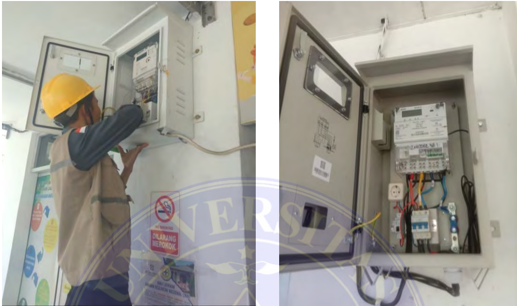
Pemasangan modem serta antenna pada meteran pelanggan
