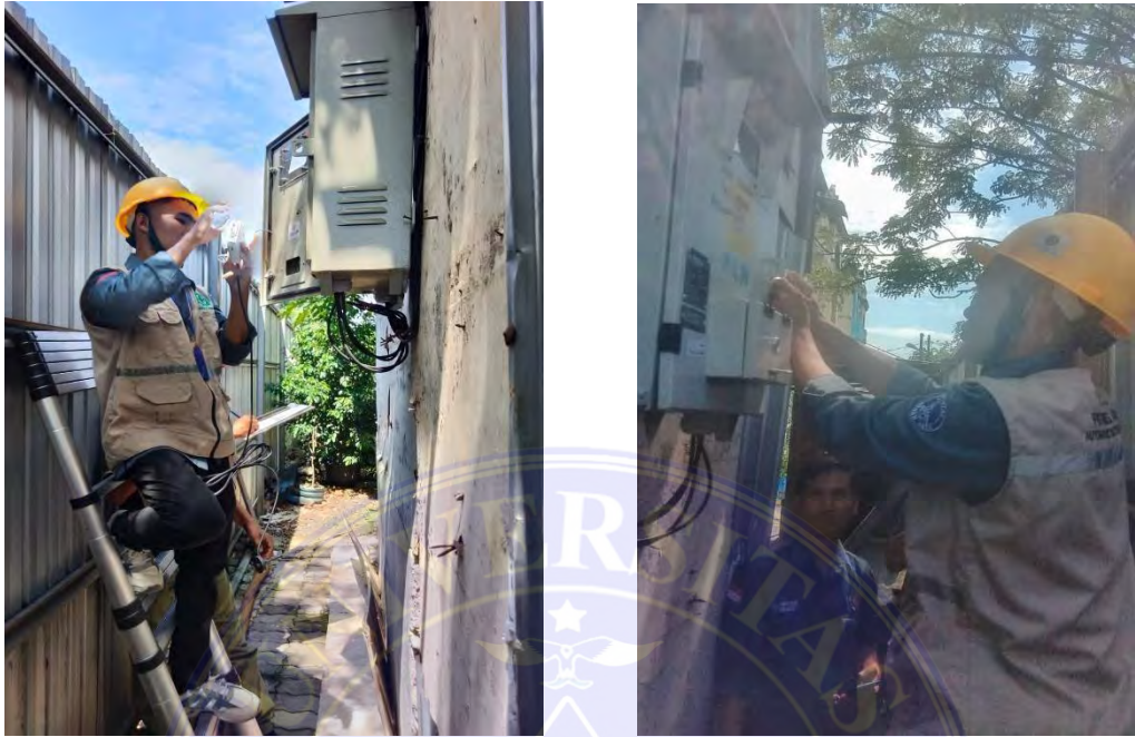
Proses penggantian modul komunikasi (Modem) kWh meter 3 phasa
