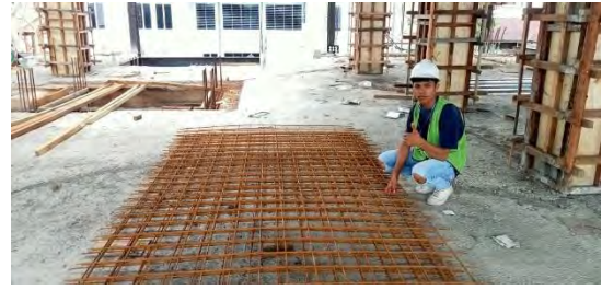
Pengecekan Besi wiremesh m7
