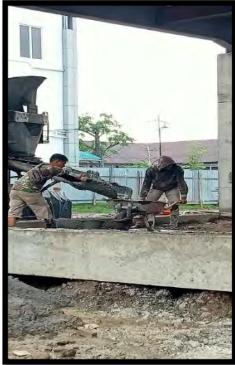
Gambar 3.5. Pengecoran kolom lantai 1 dan perakitan ring balok
