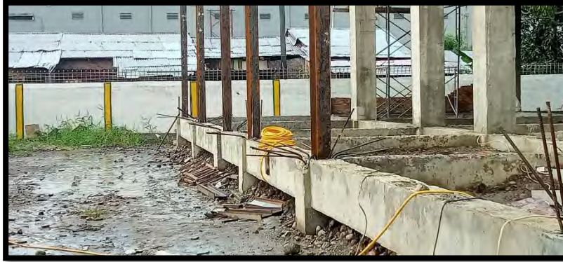
Gambar 3.3. Penyetelan tiang kolom baja
