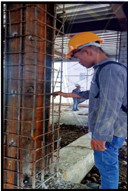
Gambar 3.4. Pemasangan mal kolom dan pemasangan besi Tulangan kolom lantai 1
