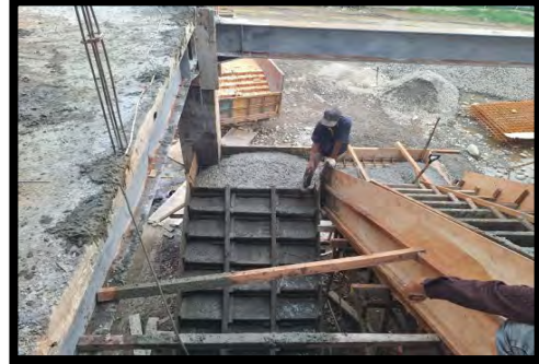
Gambar 3.15. Pemasangan plumbing dan pengecoran tangga lantai 1 dan 2
