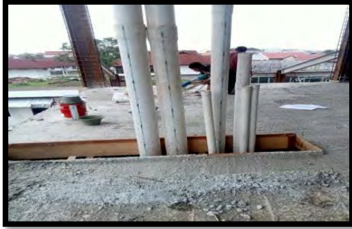
Gambar 3.15. Pemasangan plumbing dan pengecoran tangga lantai 1 dan 2
