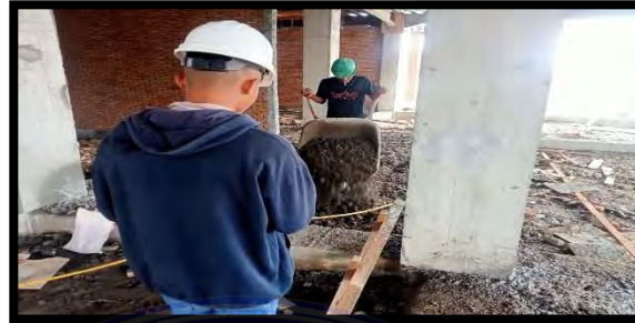
Gambar 3.9. Pemasangan mal dan pengecoran kolom lantai 2 dan penimbunan lantai dasar
