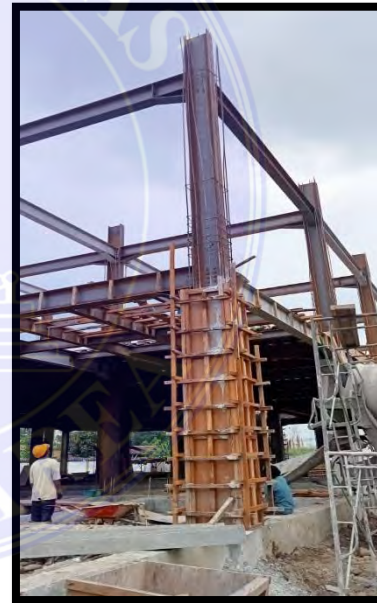
Gambar 3.4. Pemasangan mal kolom dan pemasangan besi Tulangan kolom lantai 1
