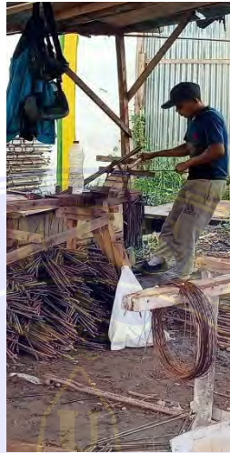
Melihat proses pembuatan cincin Tulangan kolom
