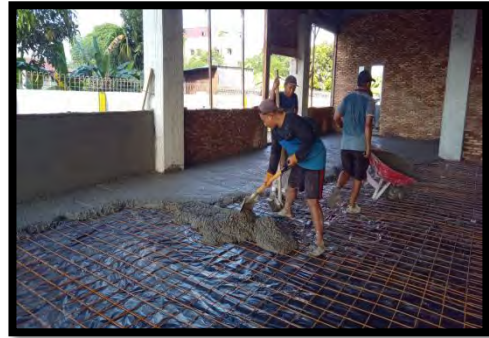
Gambar 3.11. Pemasangan besi wiremesh dan pengecoran lantai dasar
