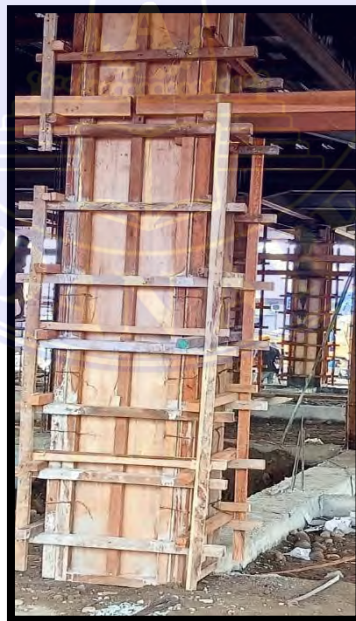
Gambar 3.2. Pemasangan mal kolom dan pengecoran kolom lantai 1
