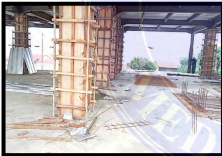
Gambar 3.10. Lanjutan pengecoran kolom lantai 2 dan penguncian ring balok
