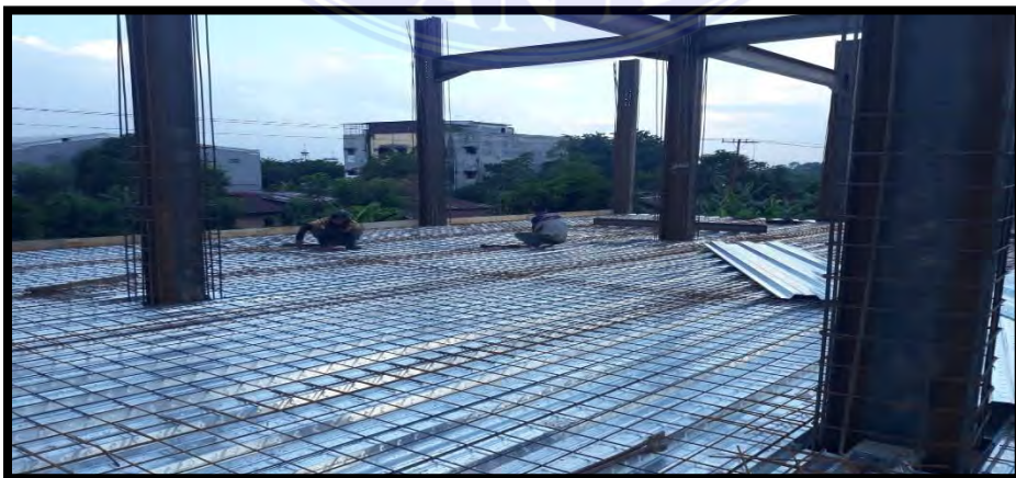
Gambar 3.6. Pemasangan bondex dan pemasangan wiremesh lantai 2
