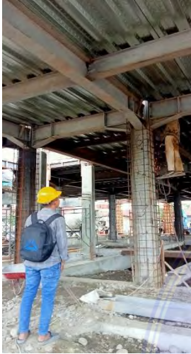
Mengetahui dan melihat cara memasang Besi Tulangan Kolom secara langsung
