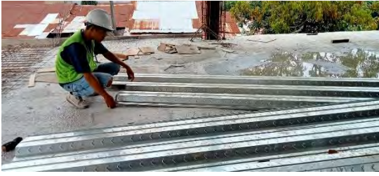
Pengecekan Bondex untuk plat lantai
