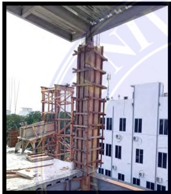
Gambar 3.12. Pengecoran kolom lantai 2 dan pemasangan batu bata di lantai 1
