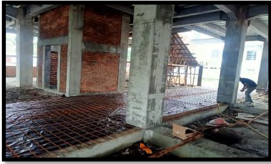
Gambar 3.11. Pemasangan besi wiremesh dan pengecoran lantai dasar
