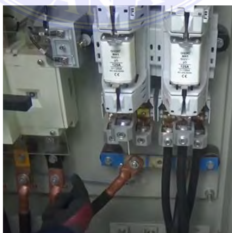
Gambar 3.9 Pemeriksaan kabel Opstyg
