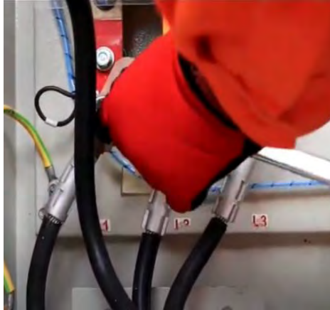
Gambar 3.10 Mengencangi Sambungan
