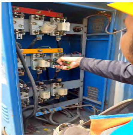
Gambar 3.2 Pelepasan NH fuse
