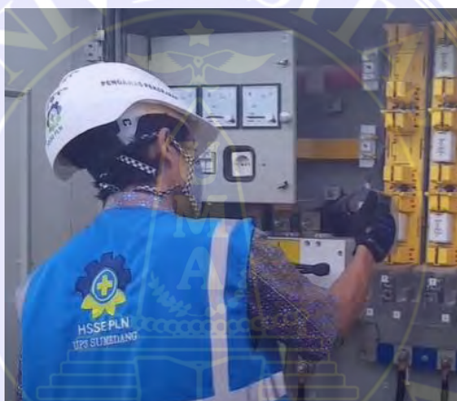
Gambar 3.16 Memasang NH fuse
