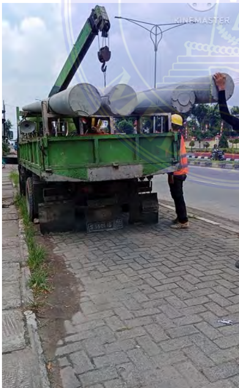
Kegiatan pemasangan tiang SUTM
