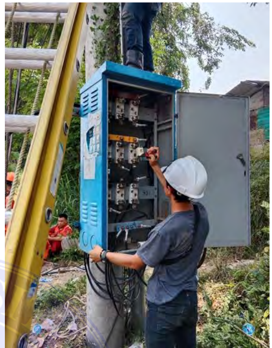
kegiatan pemasangan NT fuse
