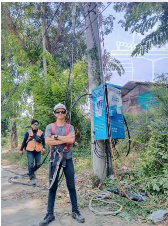
Kegiatan penggeseran trafo distribusi
