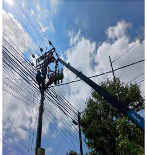
Kegiatan pemasangan LBS
