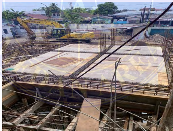
Gambar 2 Pemasangan Bekisting
