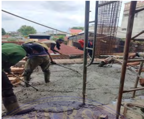
Gambar4.5 Pengecoran Plat Lantai
