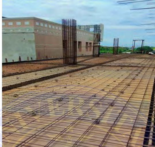
Gambar3PemasanganTulangan Sumber : Data Lapangan
