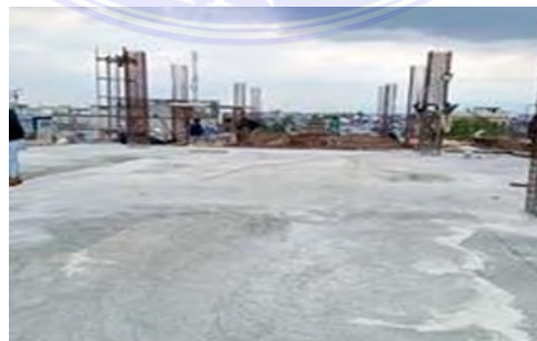
Gambar4.6 PekerjaanPembongkaranBekisting Plat Lantai
