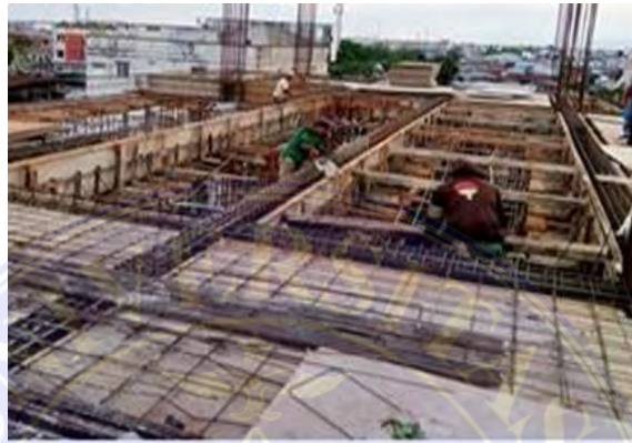
Gambar3.8 Bekisting Sumber: Data Lapangan
