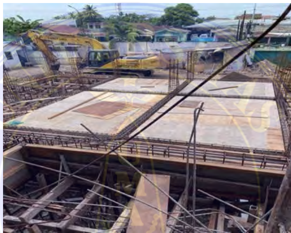
Gambar 4.3 Pemasangan Bekisting
