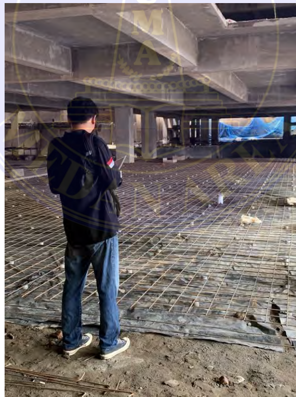
Gambar 6 Pengamatan Visual Terhadap Pengerjaan Plat Lantai
