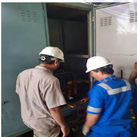
Mengukur tegangan pada panel
