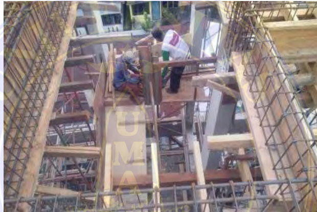
Gambar 4.3.8 Pemasangan Bekisting Balok
