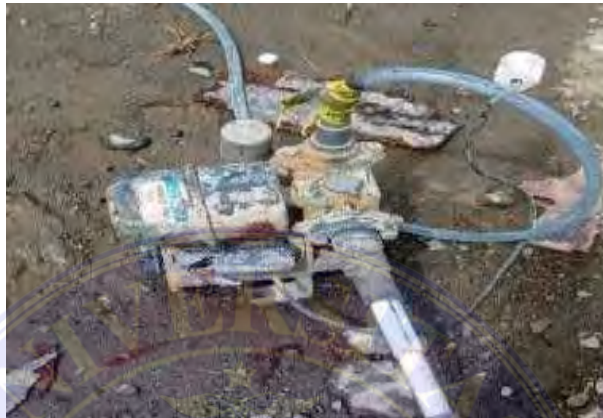
Gambar 3.1.31 Mesin Pompa Air
