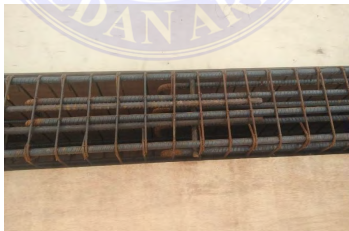
Gambar 4.3.6 Gambar Pembesian pada Balok
